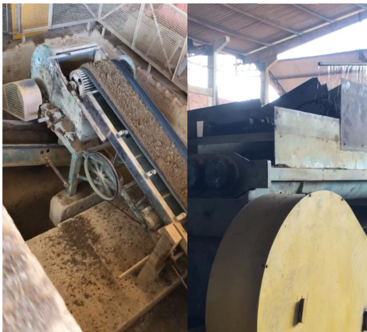
Figura 6 Transporte e trituradora de material da empresa "A"
