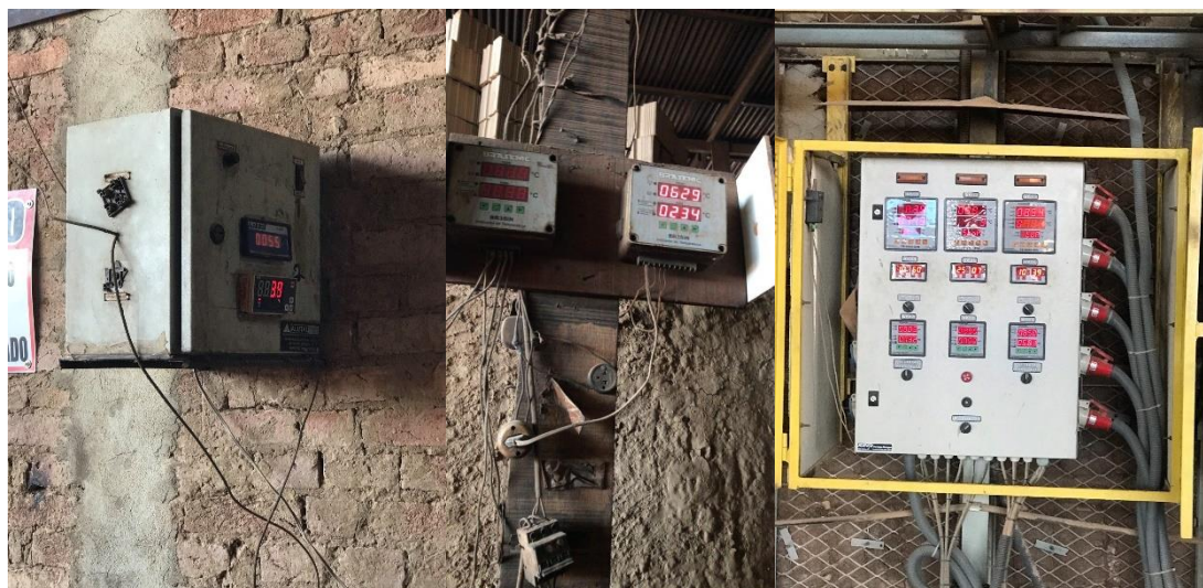
Figura 28 Demonstradores e controladores de temperatura das empresas “A”, “B” e “C”, respectivamente.
