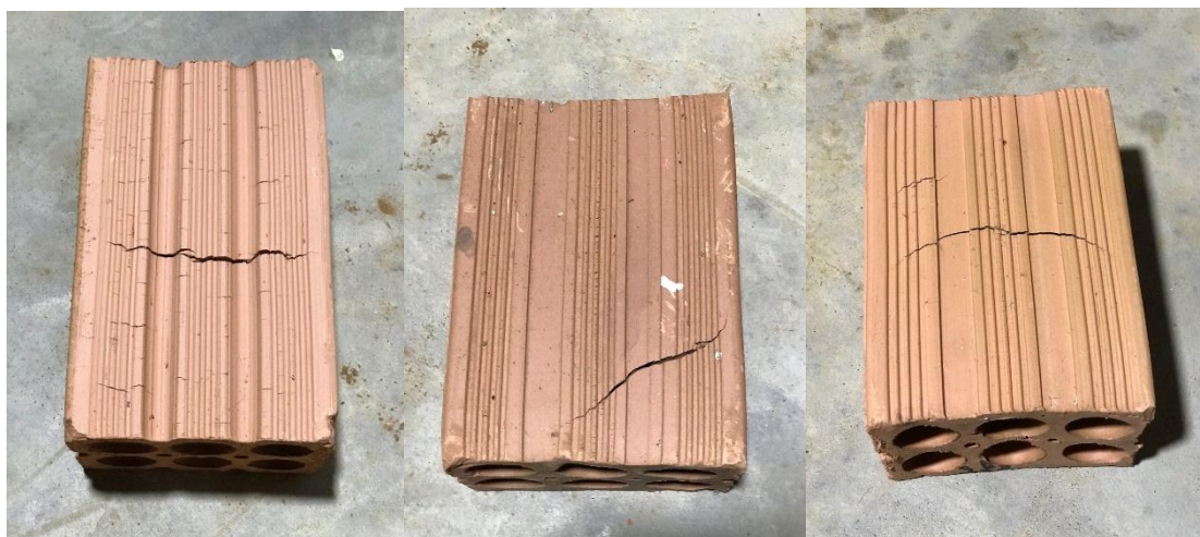
b) Tijolos com rachaduras
