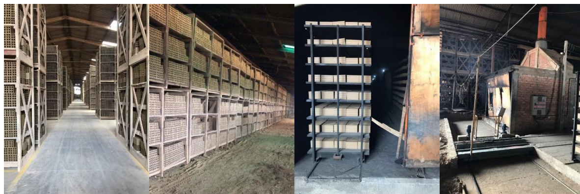
Figura 26 Disposição dos tijolos para remoção gradual da água
