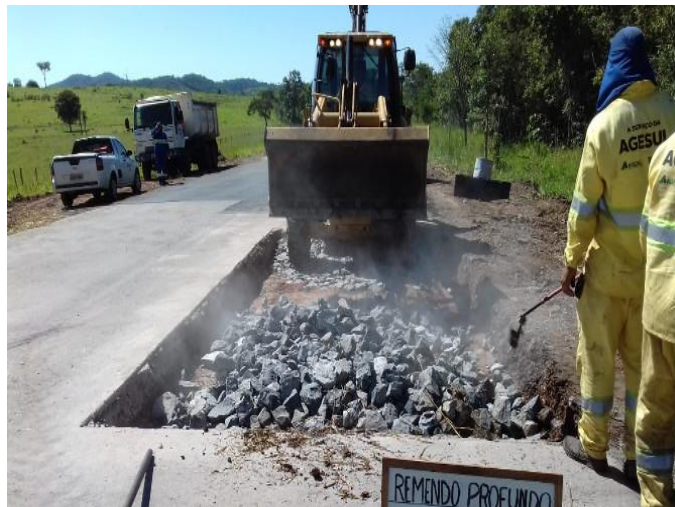
Figura 06: Remendo profundo
