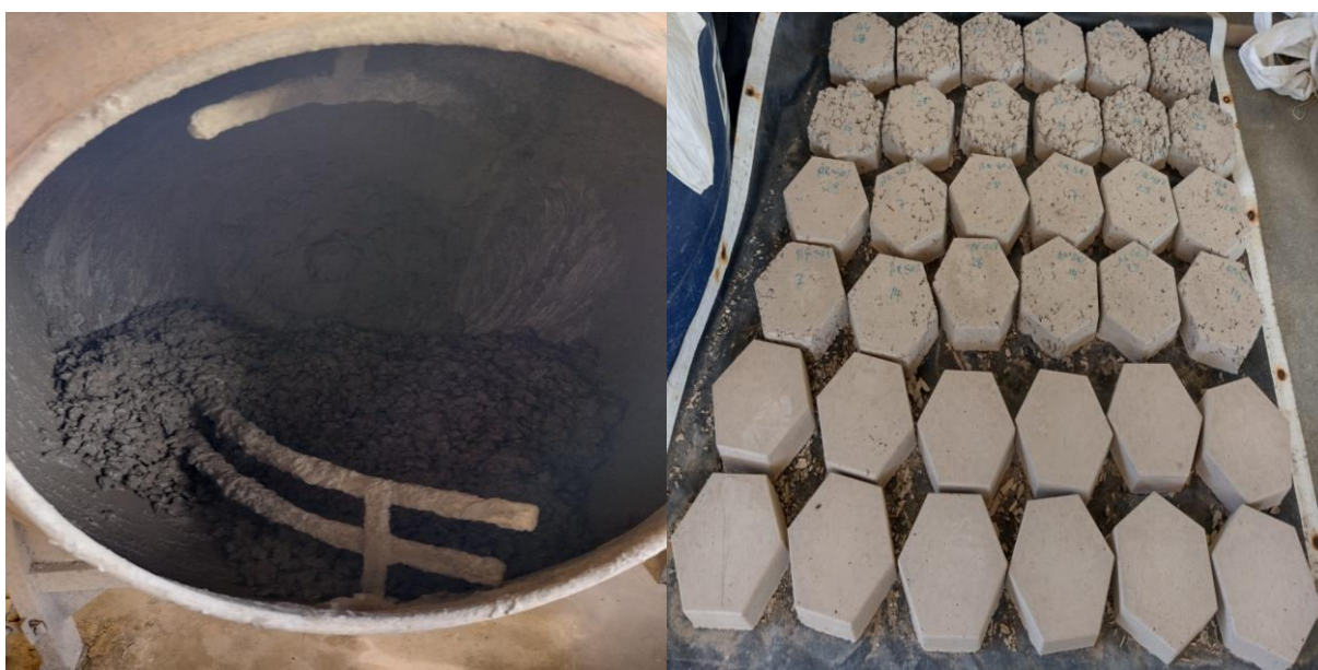
Figura 8 - Concreto e pavers
