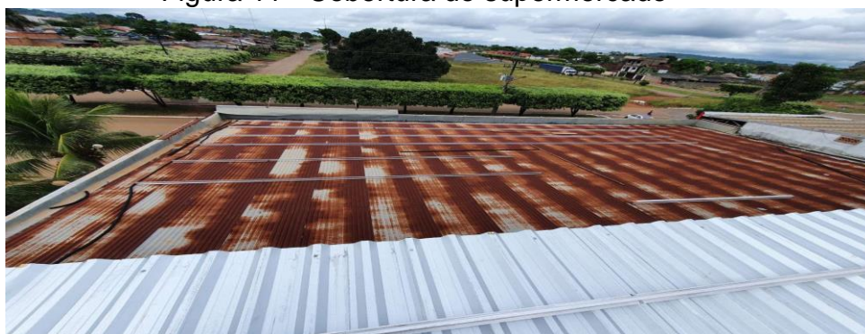
Figura 11 - Cobertura do supermercado
