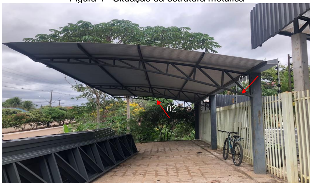
Figura 4 - Situação da estrutura metálica
