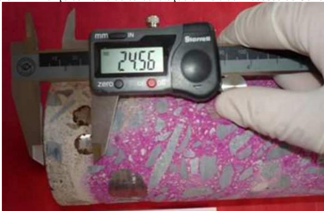
Figura 12 - Avanço da frente de carbonatação e Início do Processo de Corrosão
