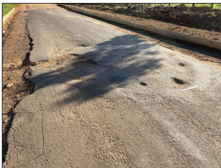
Figura 25 – Remendos Trecho A (b)
