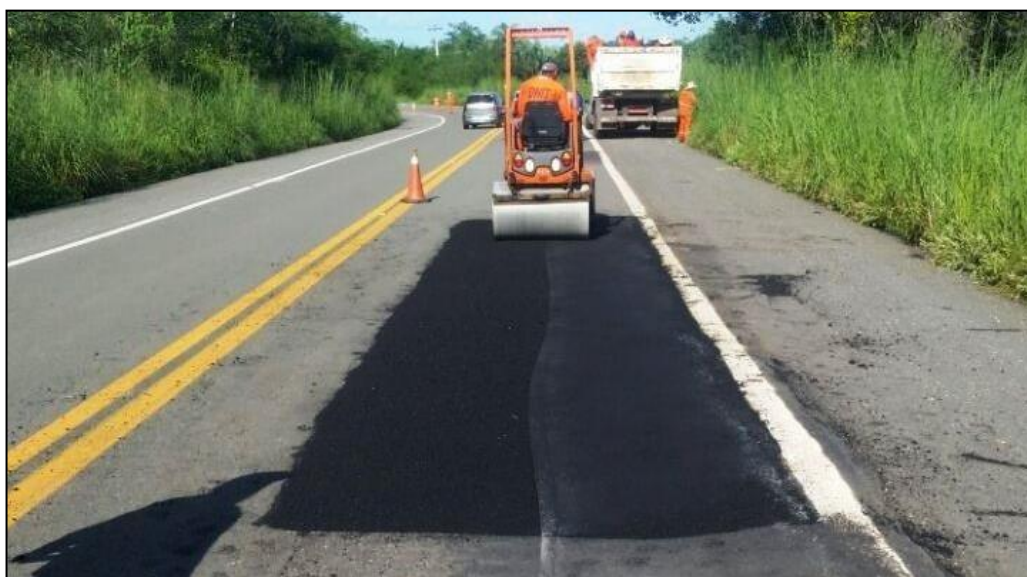
Figura 14 – Remendo asfáltico
