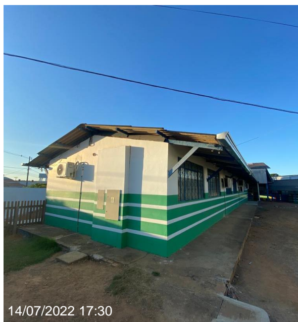
Figura 11 - Fachada Sul e Leste (Bloco C) da edificação analisada
