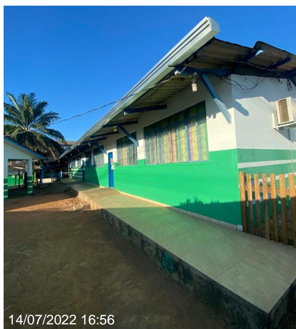
Figura 10 - Fachada Norte e Sul (Bloco C) da edificação analisada
