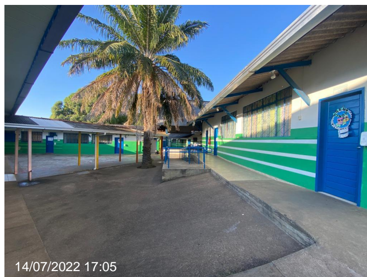
Figura 8 - Dependências da edificação analisada
