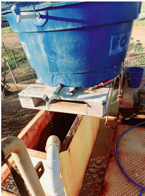
Figura 19 - Dosador do coagulante
