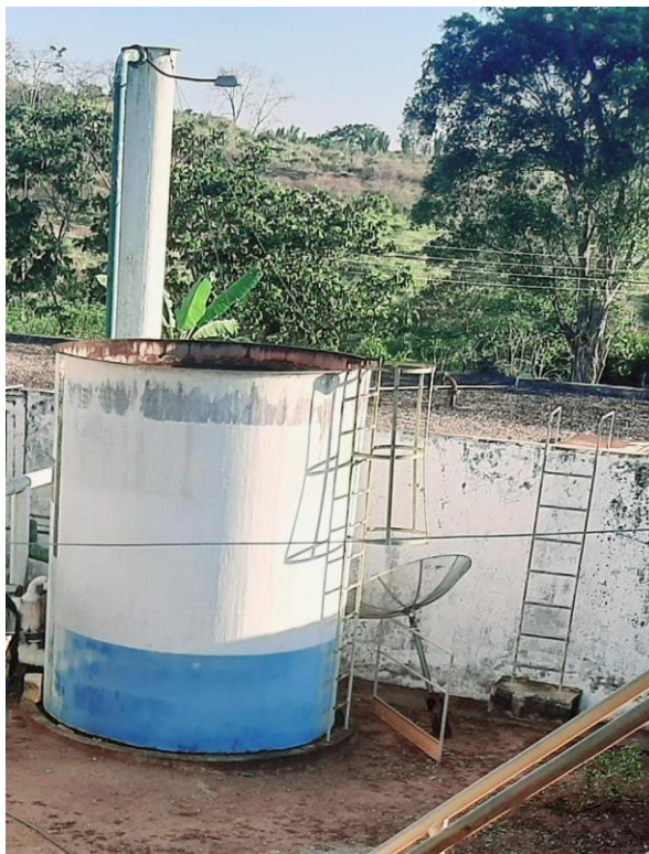
Figura 23 - Reservatório de água
