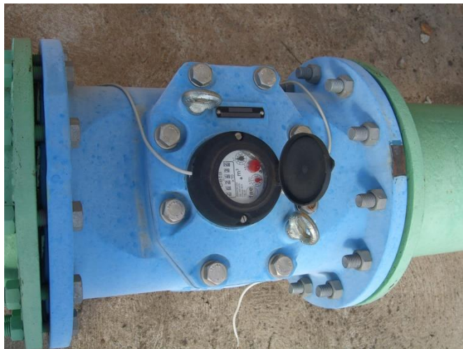
Figura 10 - Macro medidor de vazão
