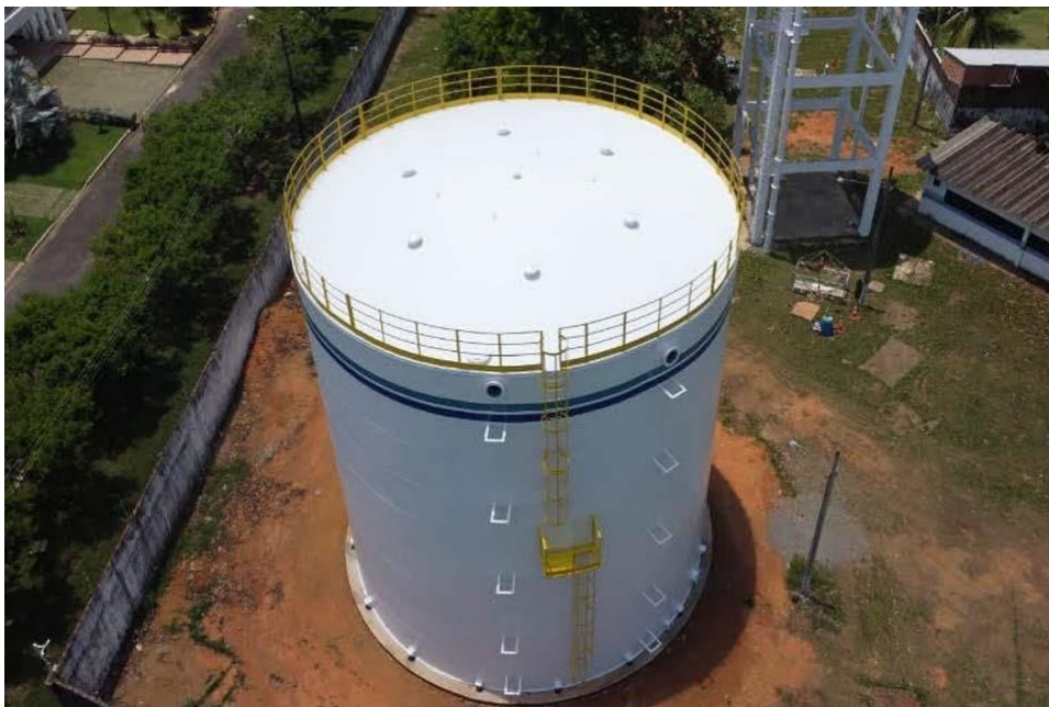
Figura 8 - Reservatório de água tratada
