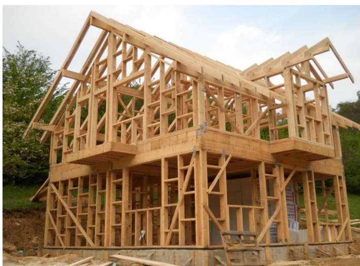
Figura 4 - Sistema Light Wood Frame
