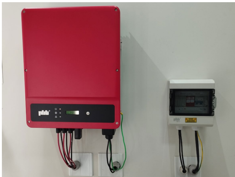
Figura 14 – Inversor solar On-grid com caixa de proteção
