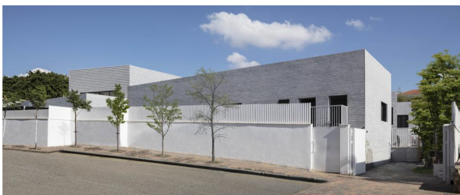
Figura 02 – Fachada do abrigo para vítimas de violência doméstica em Israel
