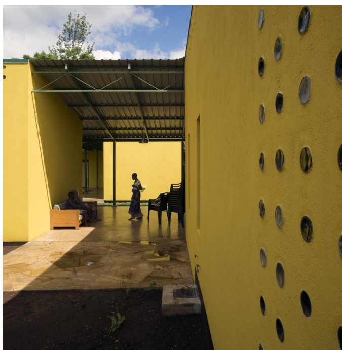
Figura 18 – Parede com garrafas
