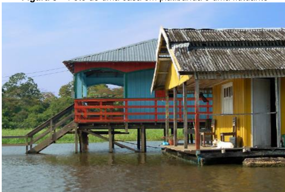
Figura 3 – Foto de uma casa em platibanda e uma flutuante
