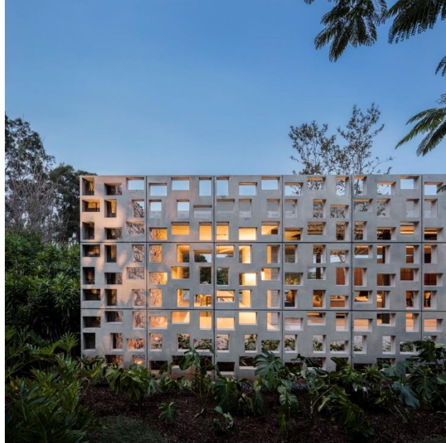
Figura 43 – Parede de cobogós da Casa Pasqua
