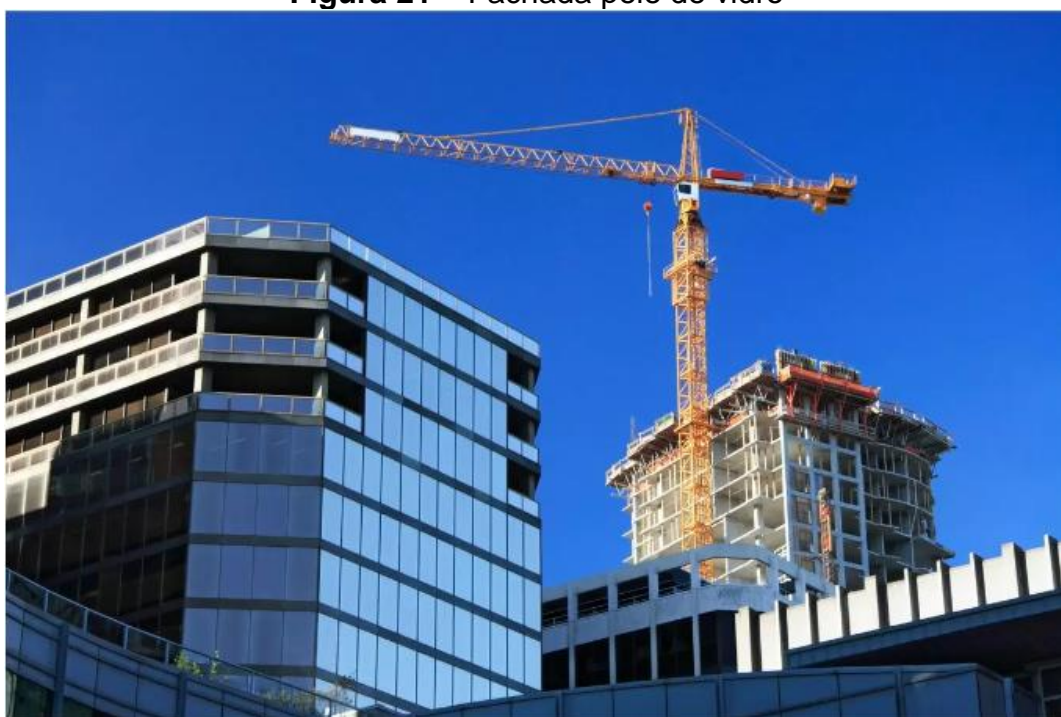
Figura 21 – Fachada pele de vidro
