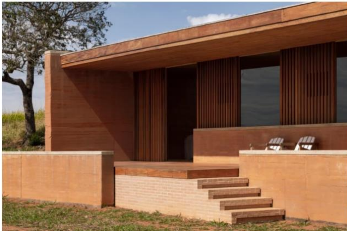
Figura 25 – Taipa de pilão
