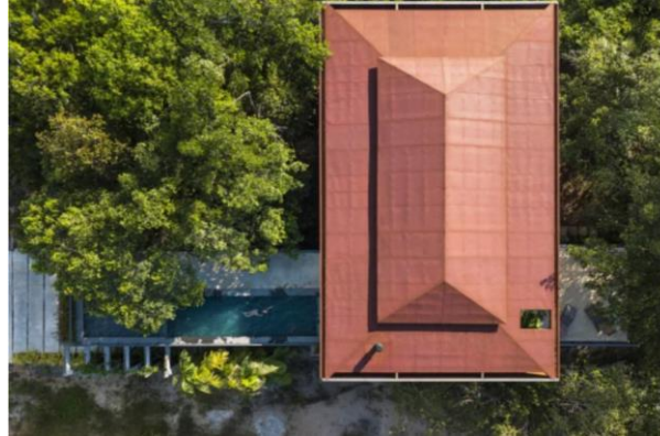
Figura 31 – Vista aérea da cobertura da Casa Campinarana
