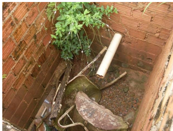
Foto 29 - Caixa de passagem de drenagem em material inadequado (alvenaria de 1/2x)
