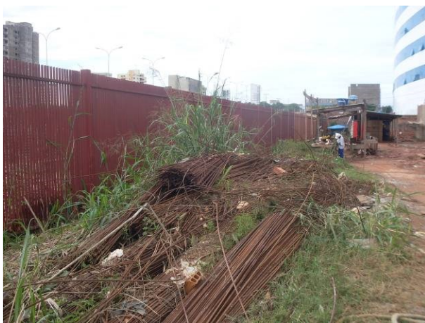
Foto 37-Ferragem junto a obra de auditório em contato com solo e vegetação, cuja utilização pode comprometer a qualidade da estrutura. Foto 38 – Viga de auditório com defeitos de concretagem
