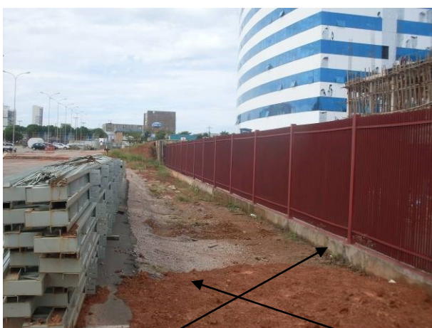
Foto 6- Pátio pavimentado para estacionamento e postes de iluminação.
