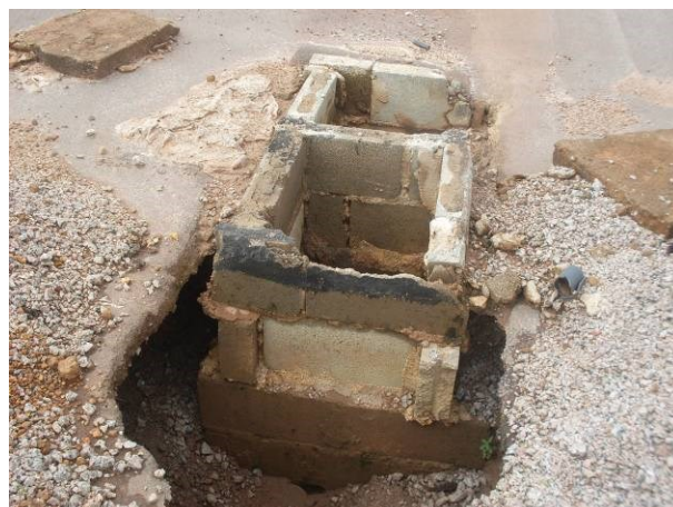
F31- Acúmulo de sedimentos por deficiente escoamento pluvial. F32 - Sedimento de pavimento junto a caixa passagem.
