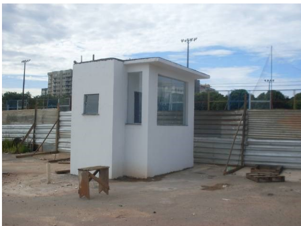
Foto 5- Uma das guaritas em fase final de execução.
