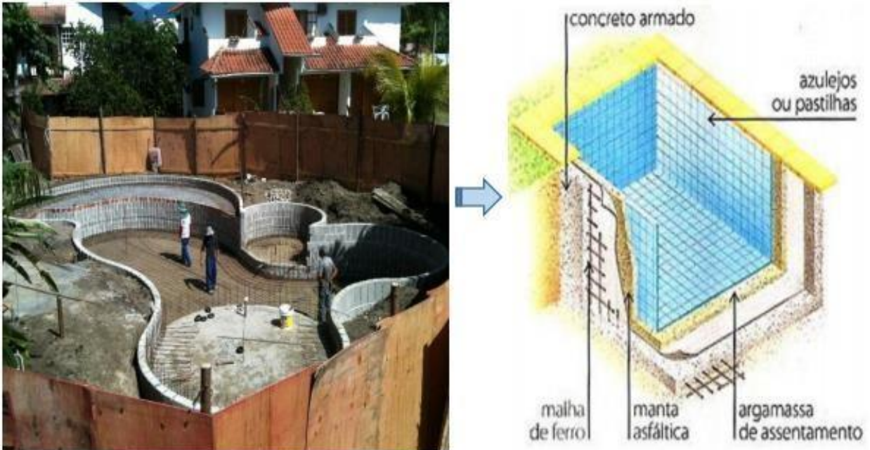
Figura 4 - Esquema estrutural de uma piscina alvenaria
