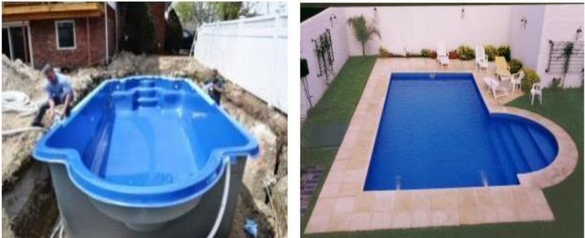
Figura 7 – Instalação da Piscina de fibra de vidro
