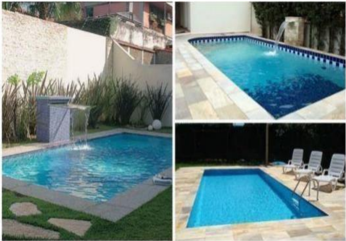
Figura 3 - Piscinas de Alvenaria Finalizadas
