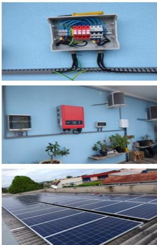
Figura 5 - Instalação do sistema de energia solar
