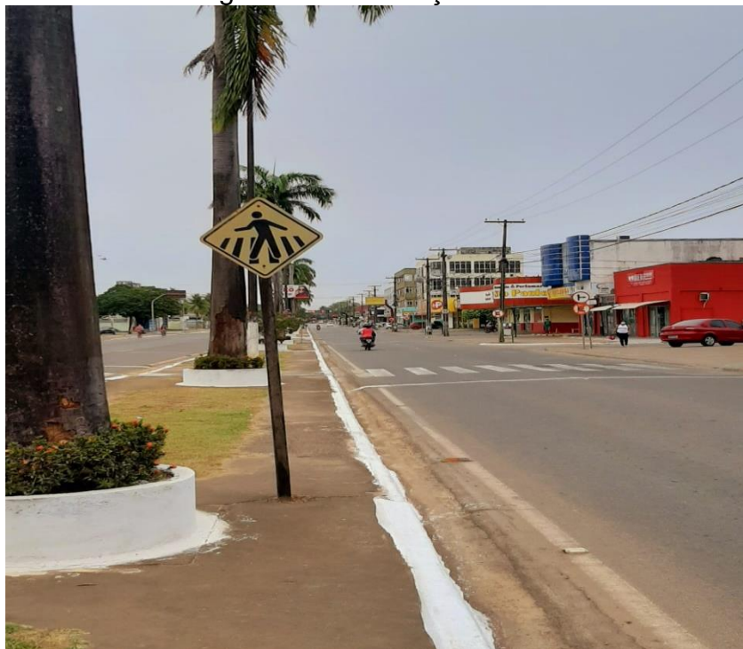
Figura 25: Sinalização na via
