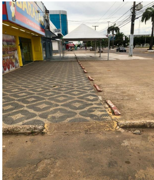
Figura 29 – Ausência de rampa
