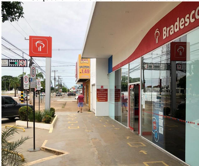
Figura 41 – Calçada em frente ao Banco Bradesco fora das normas
