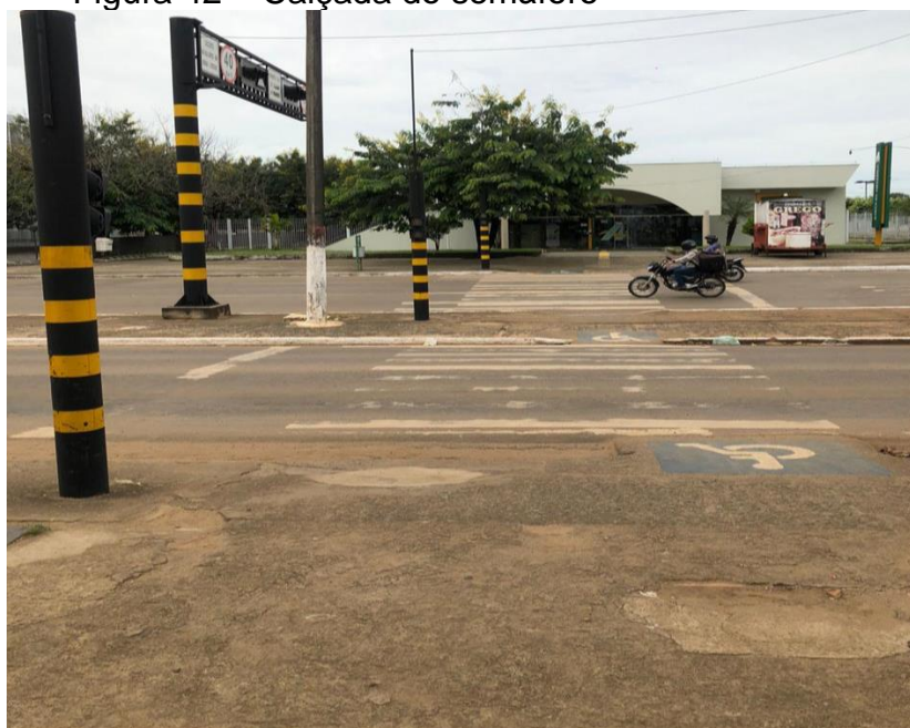
Figura 42 – Calçada do semáforo
