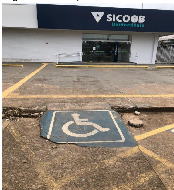
Figura 28 – Rampa danificada
