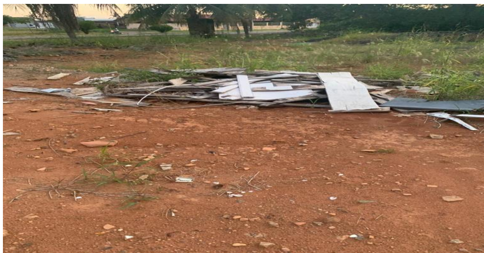
Figura 12-Resíduos de RCD - deposição irregular Setor 05
