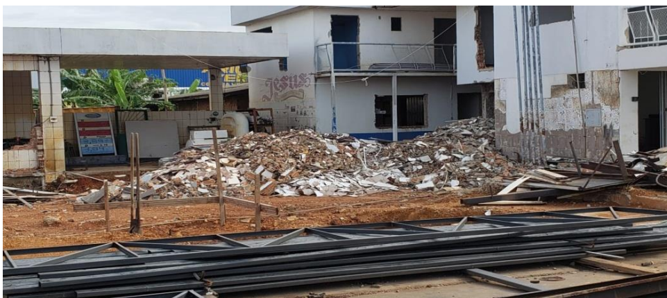
Figura 7-RCD- demolição de alvenaria
