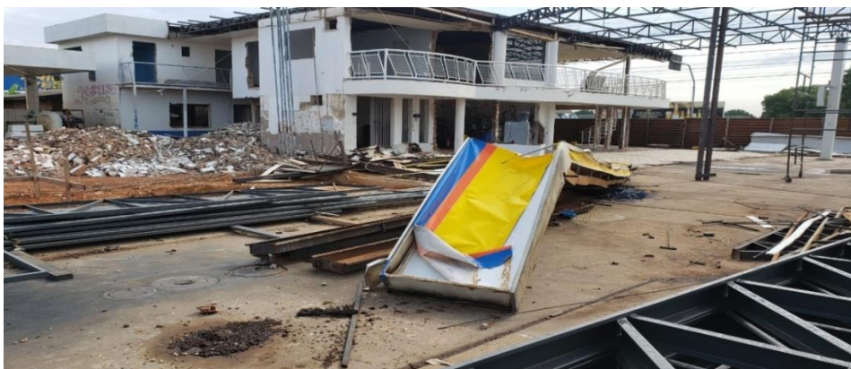
Figura 8-RCD- Demolição de estrutura metálica
