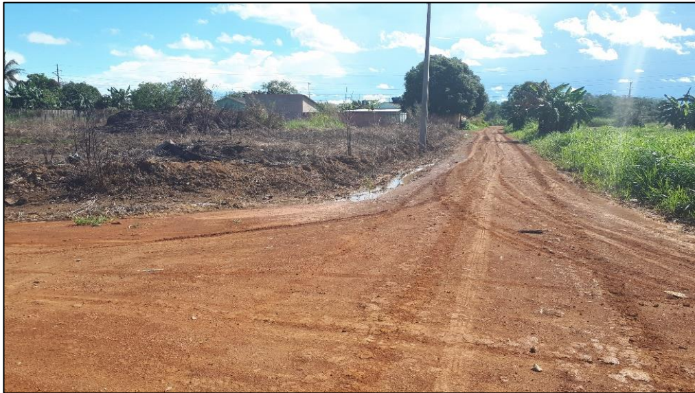
Figura 9 – Ruas sem pavimentações.
