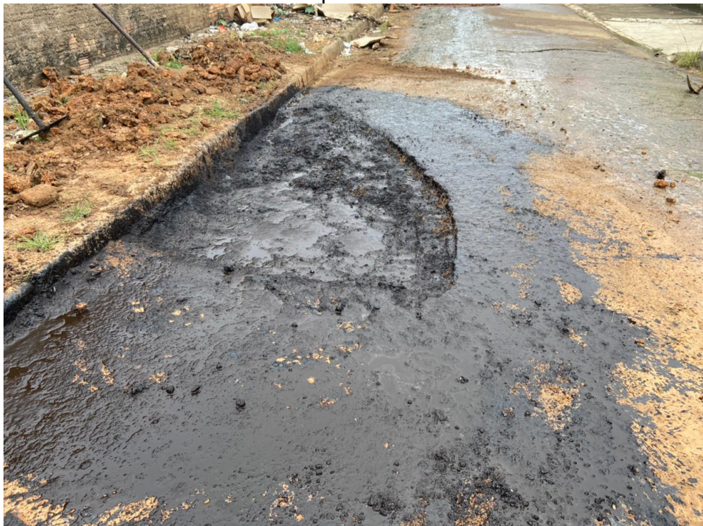
Figura 31 - Aplicação de emulsão asfáltica no processo de recuperação da patologia panela
