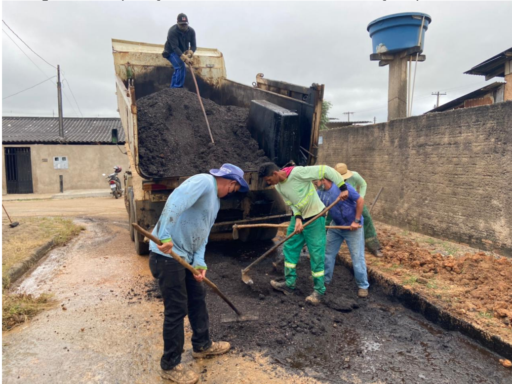
Figura 39 - Aplicação da massa asfáltica no serviço tapa buraco
