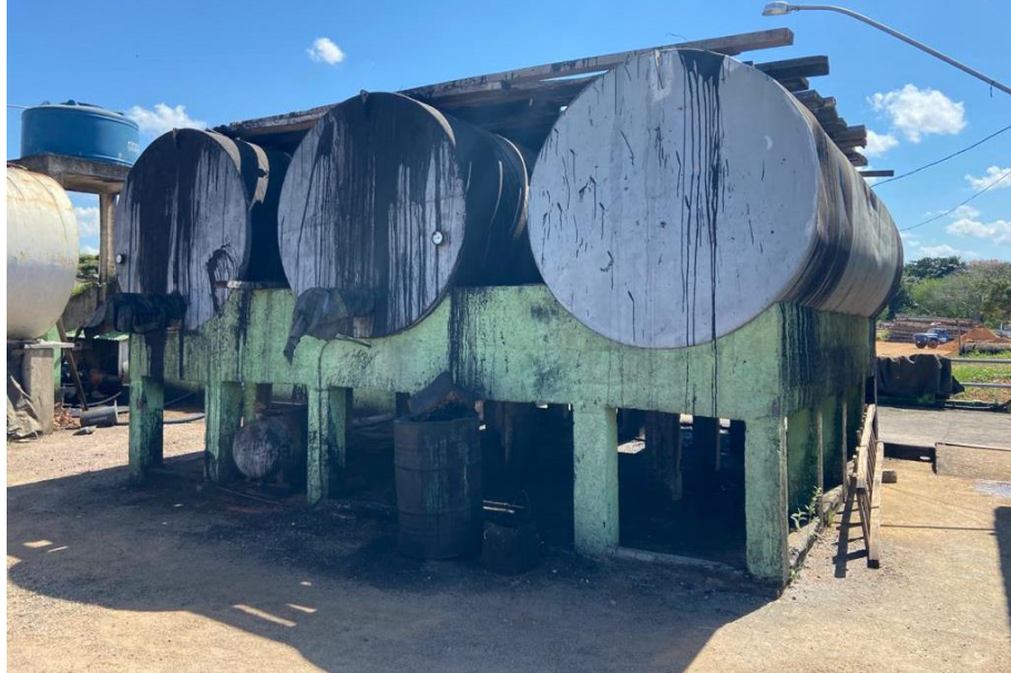
Figura 37 - Tanques para armazenamento de emulsão asfáltica
