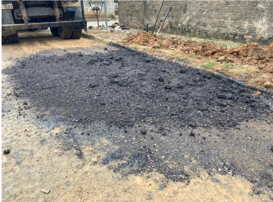
Figura 40 - Aplicação da massa asfáltica para tapa buraco
