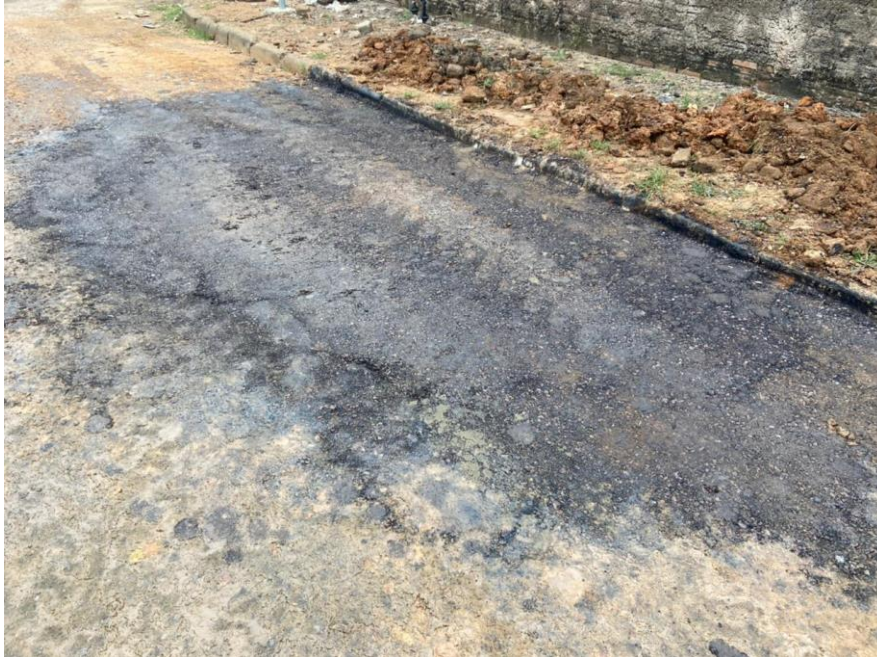
Figura 42 - Recuperação da patologia panela finalizada
