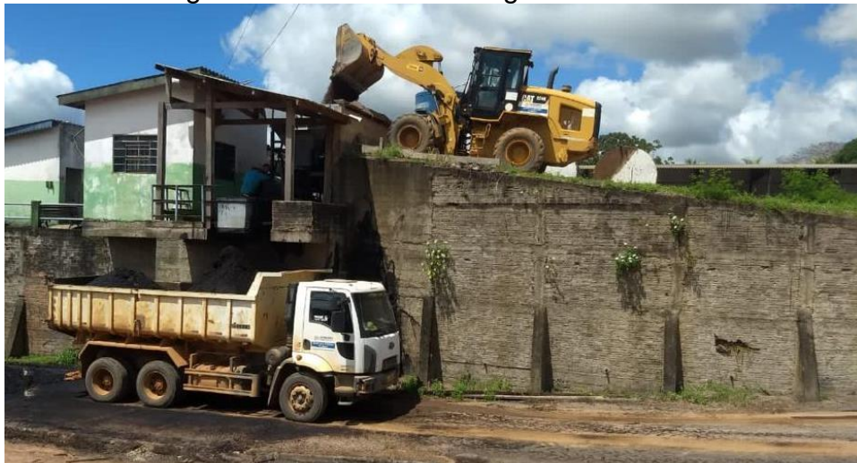
Figura 38 - Área de descarga do caminhão
