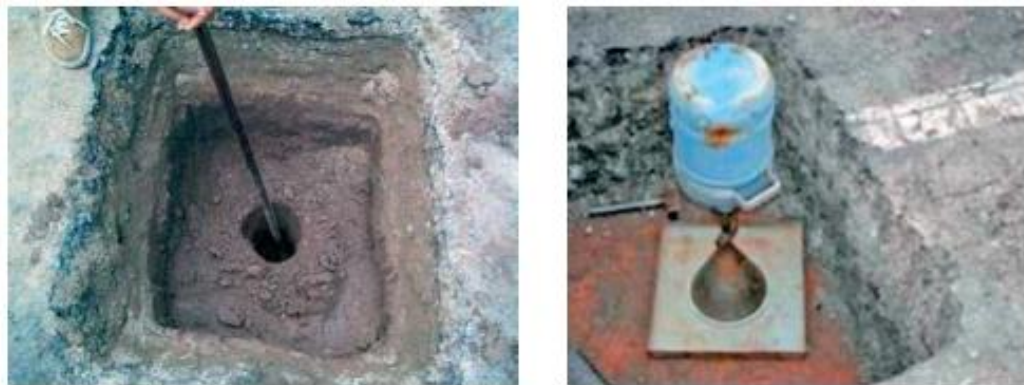
Figura 3 - Exemplo de poços de sondagem em pavimentos em uso
