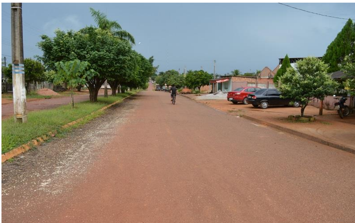
Figura 17 – Vista da Avenida Afonso Gago setor 03 e 04
