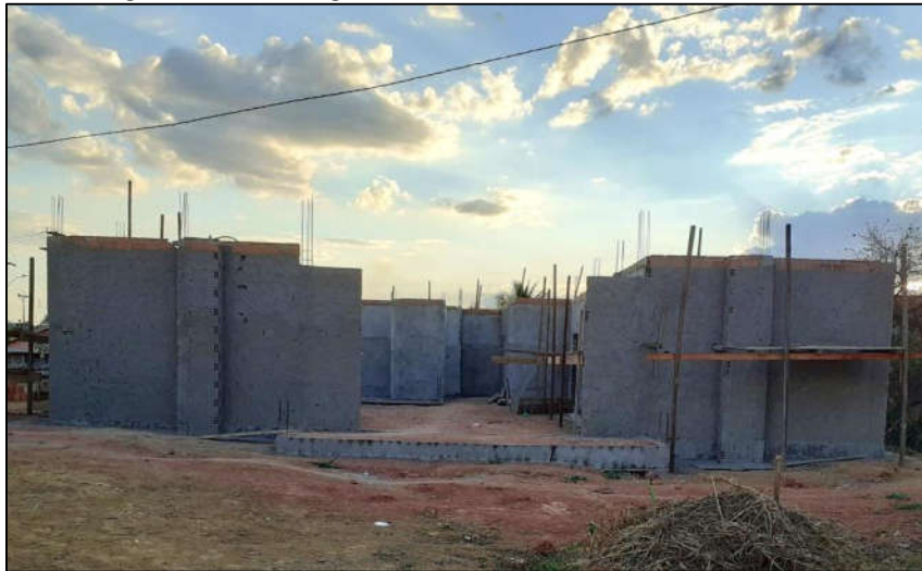
Figura 19 - Estágio da obra 3 no momento da visita.
