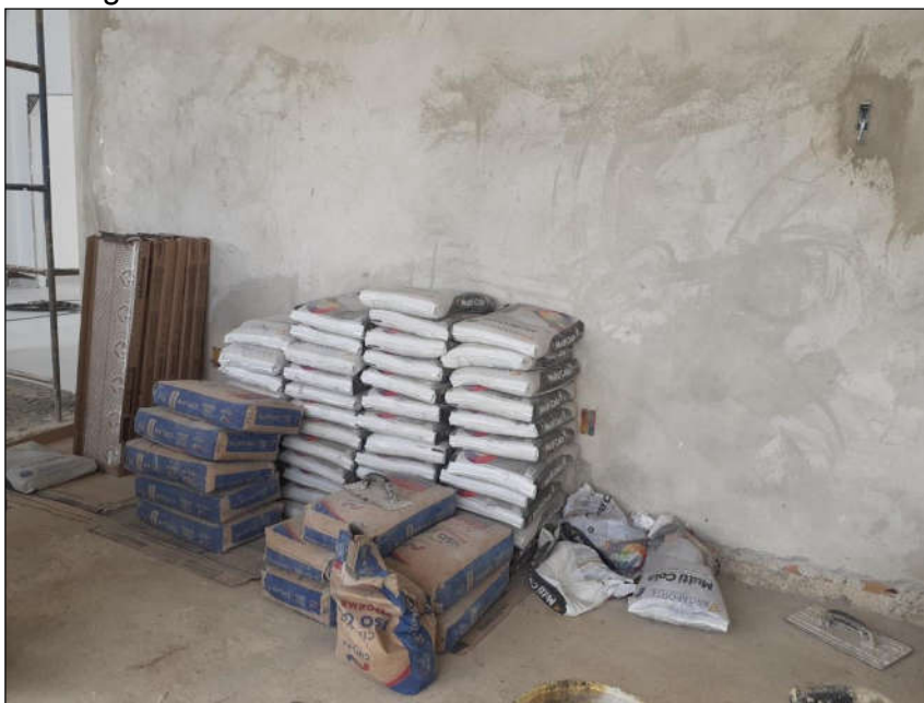
Figura 16 - Materiais estocados do canteiro de obra 2.
