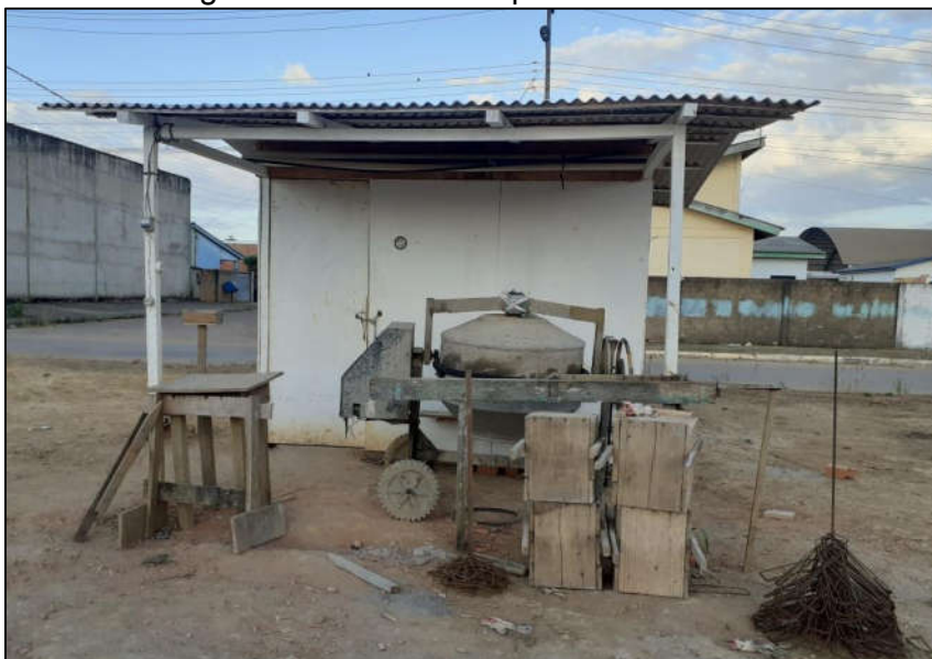
Figura 20 - Área de carpintaria da obra 3.
