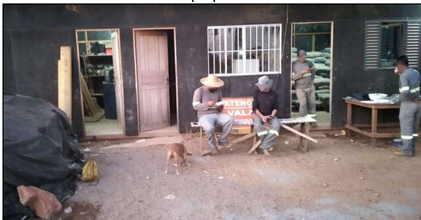
Figura 26 - Trabalhadores do canteiro 4 realizando café da manhã em local inapropriado.
