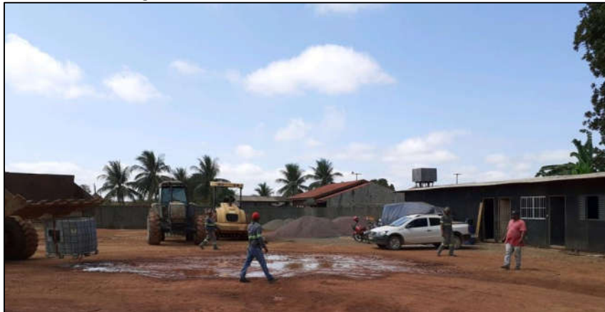
Figura 23 - Sede do canteiro da obra 4.
