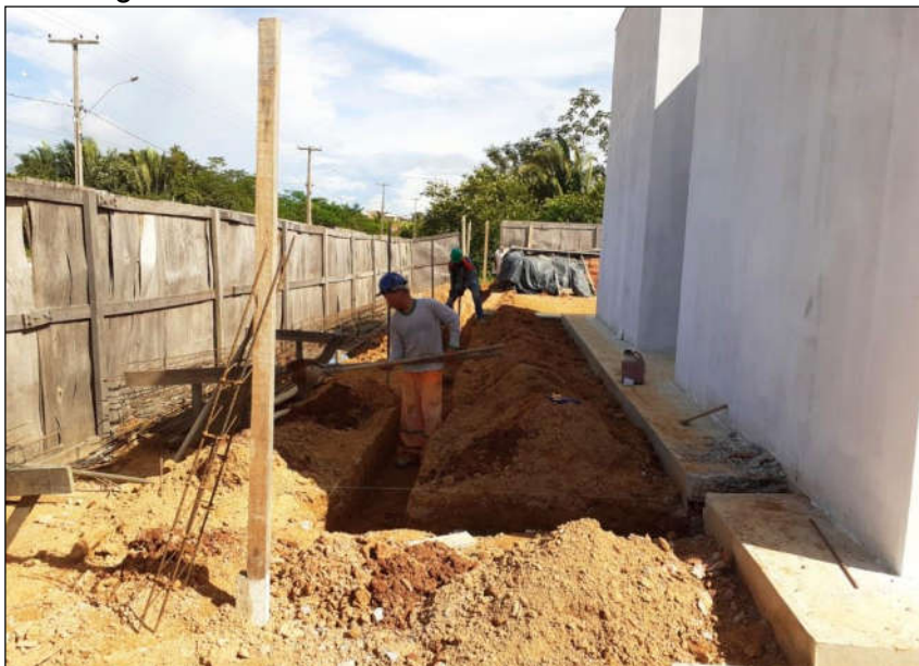
Figura 13 - Trabalhadores utilizando EPIs na obra 1.
