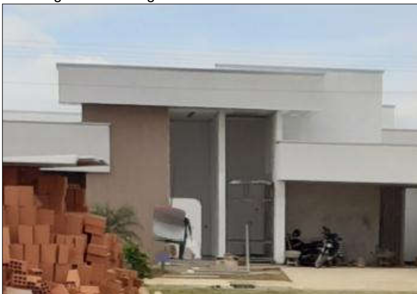
Figura 15 - Estágio da obra 2 no momento da visita.
