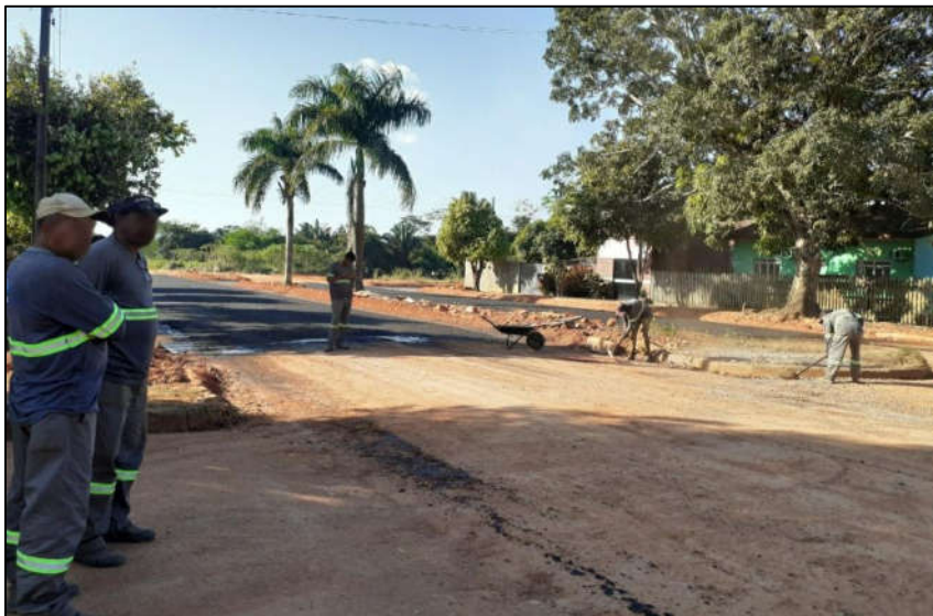
Figura 24 - Trabalhadores da obra 4 utilizando uniformes com tiras refletivas.
