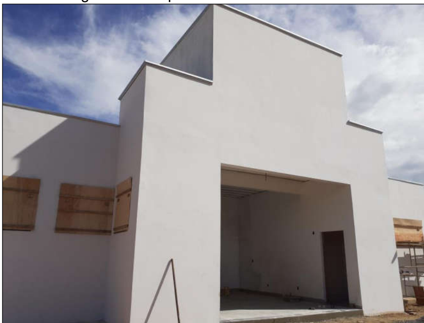
Figura 12 - Etapa da obra 1 no ato da visita.
