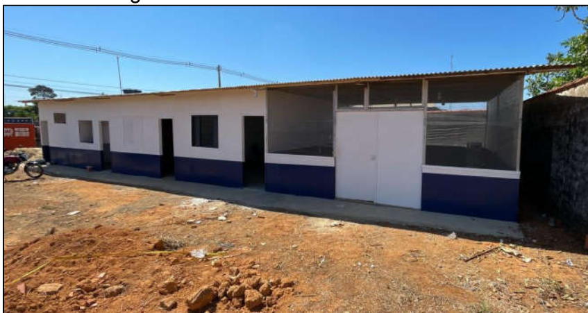
Figura 27 - Sede do canteiro de obras 5.
