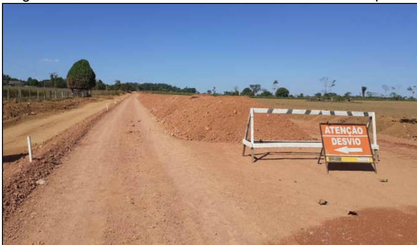
Figura 25 - Trecho da obra 4 sinalizado com cavalete e placa.
