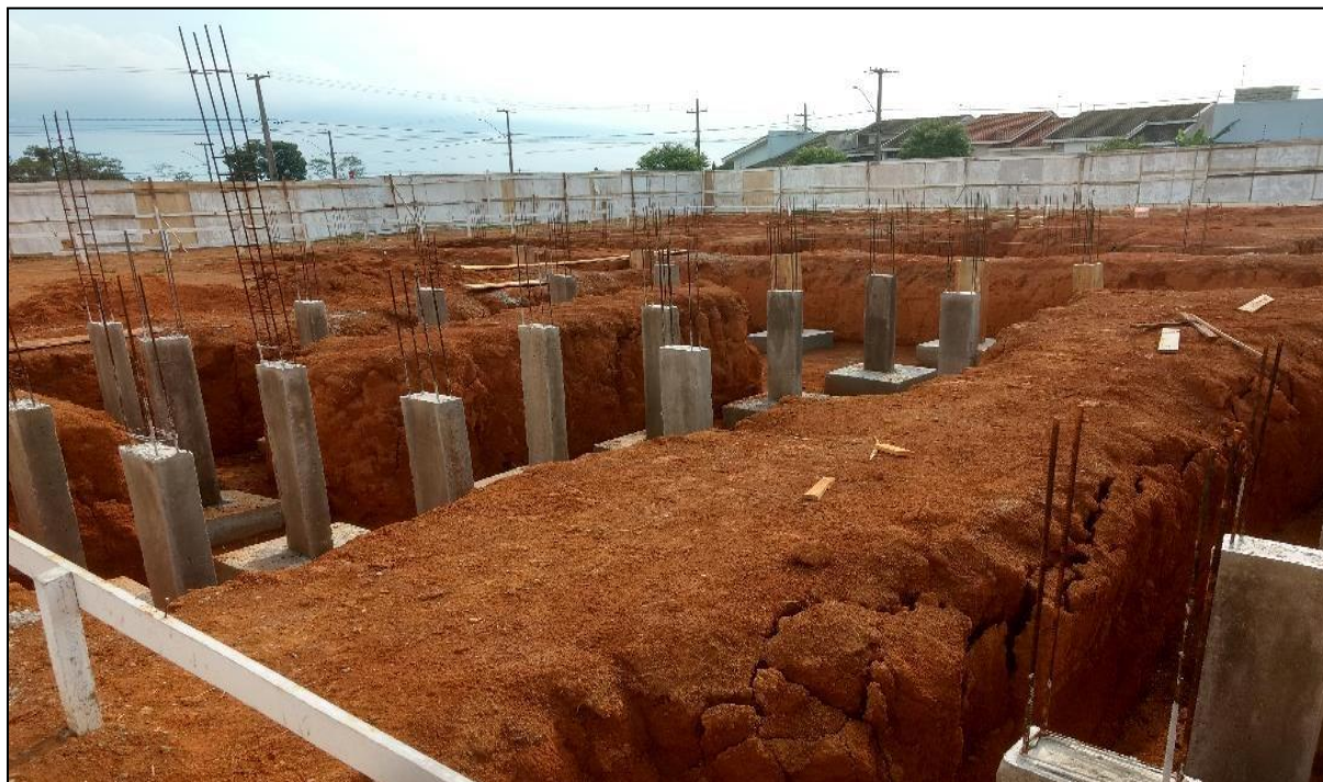
Figura 18 - Pilares de arranque concretados
