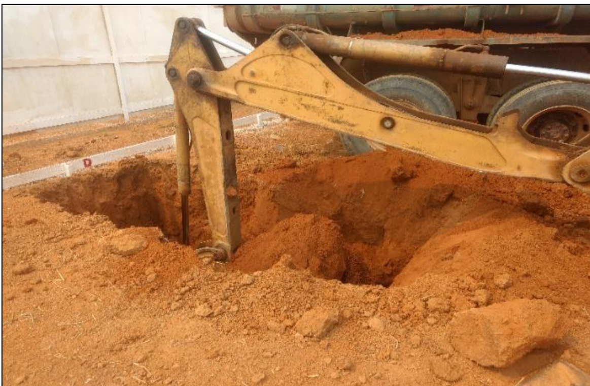
Figura 7 - Processo de movimentação de terra
