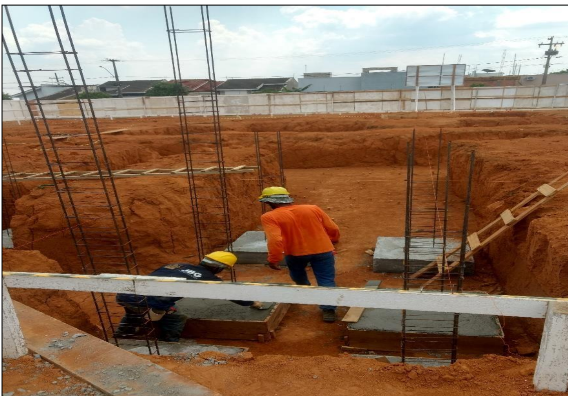
Figura 14 - Processo de concretagem das sapatas de 90x90cm
