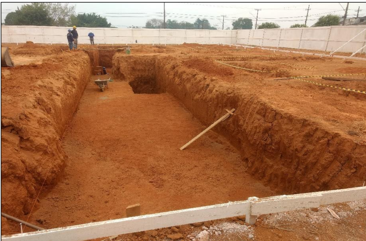
Figura 9 - Processo das escavações
