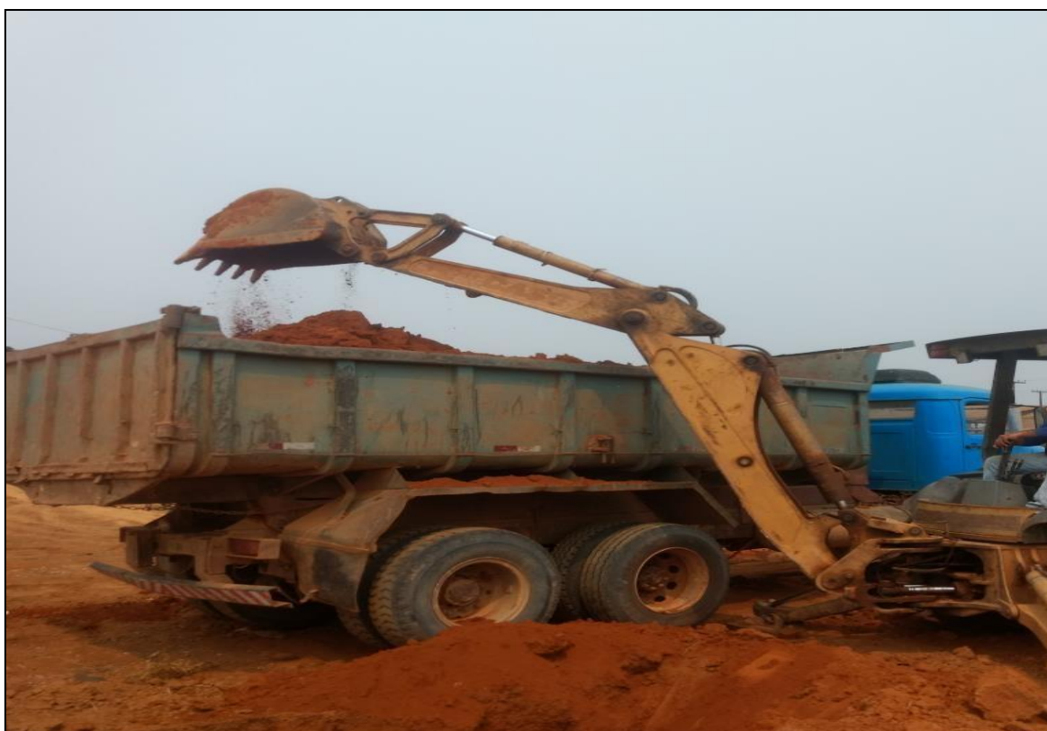
Figura 8 - Processo de movimentação de terra
