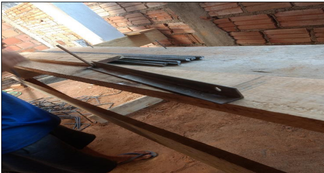
Figura 11 - Ferramenta utilizada para auxiliar na dobragem das ferragens
