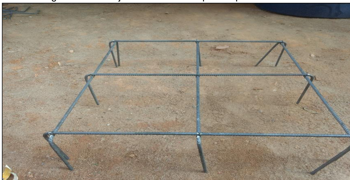
Figura 12 - Armação confeccionada para sapata 90x90cm
