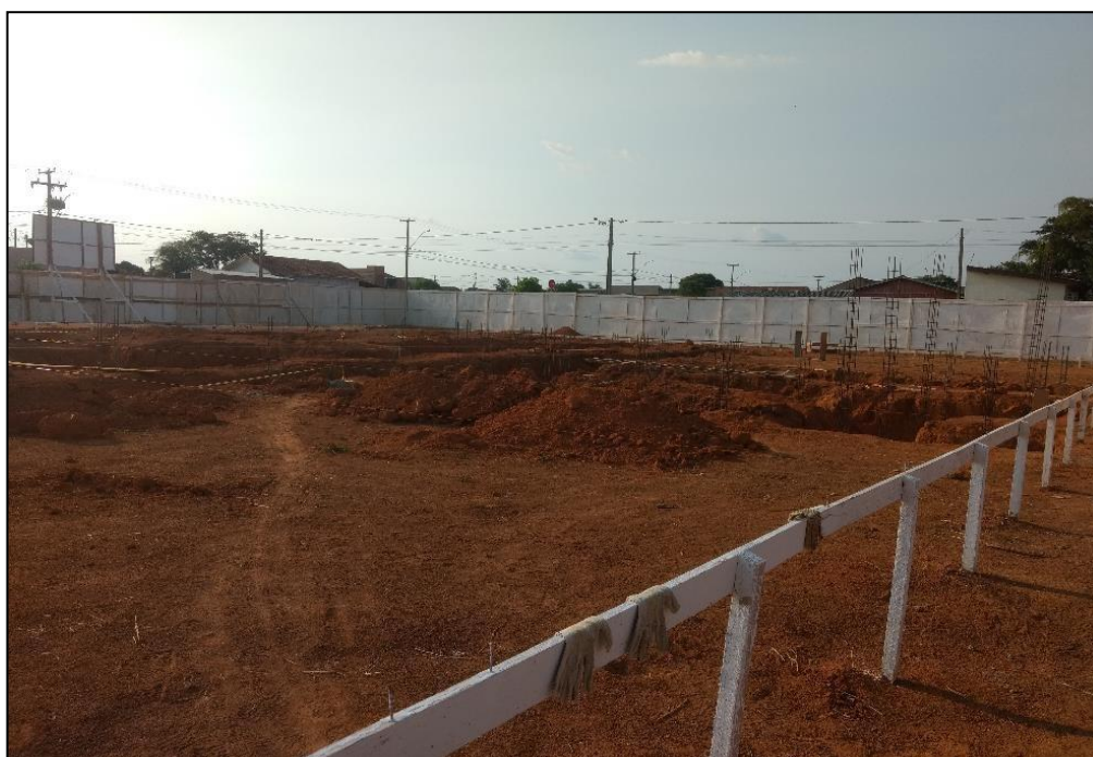
Figura 5 - Gabarito já finalizado com as devidas especificações feitas
