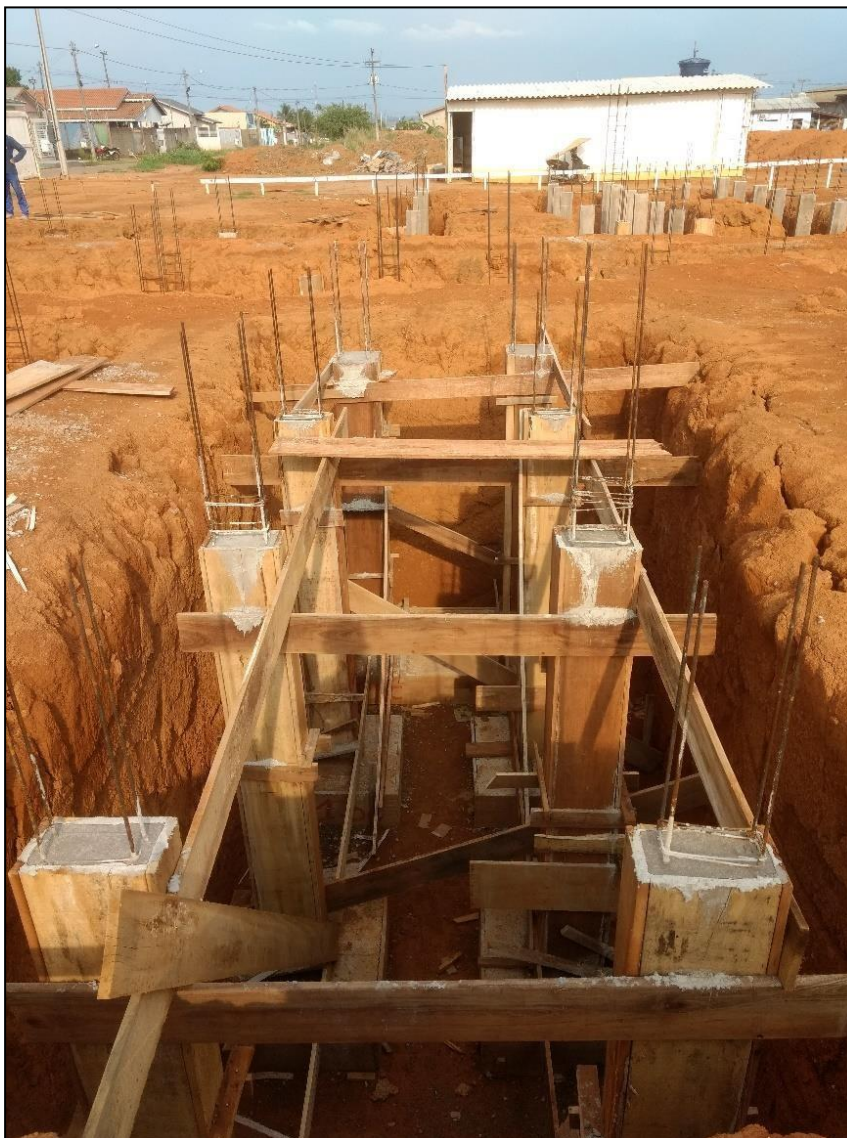
Figura 19 - Pilares de arranque concretados
