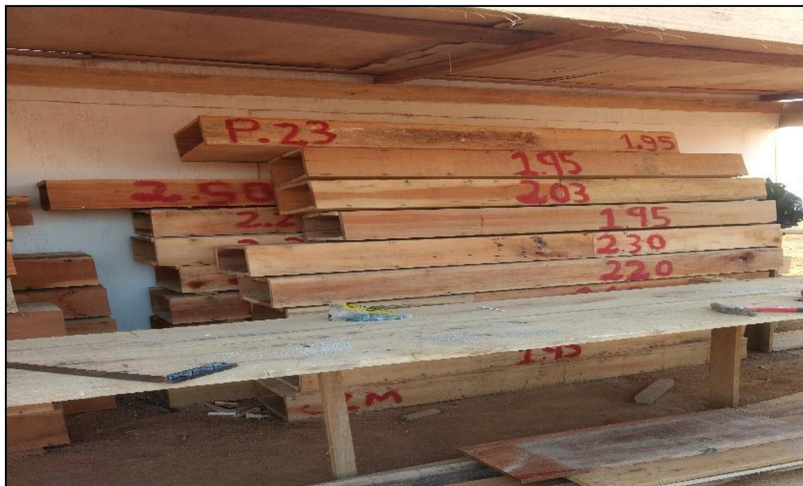
Figura 17 - Confecção das fôrmas para concretagem dos pilares de arranque
