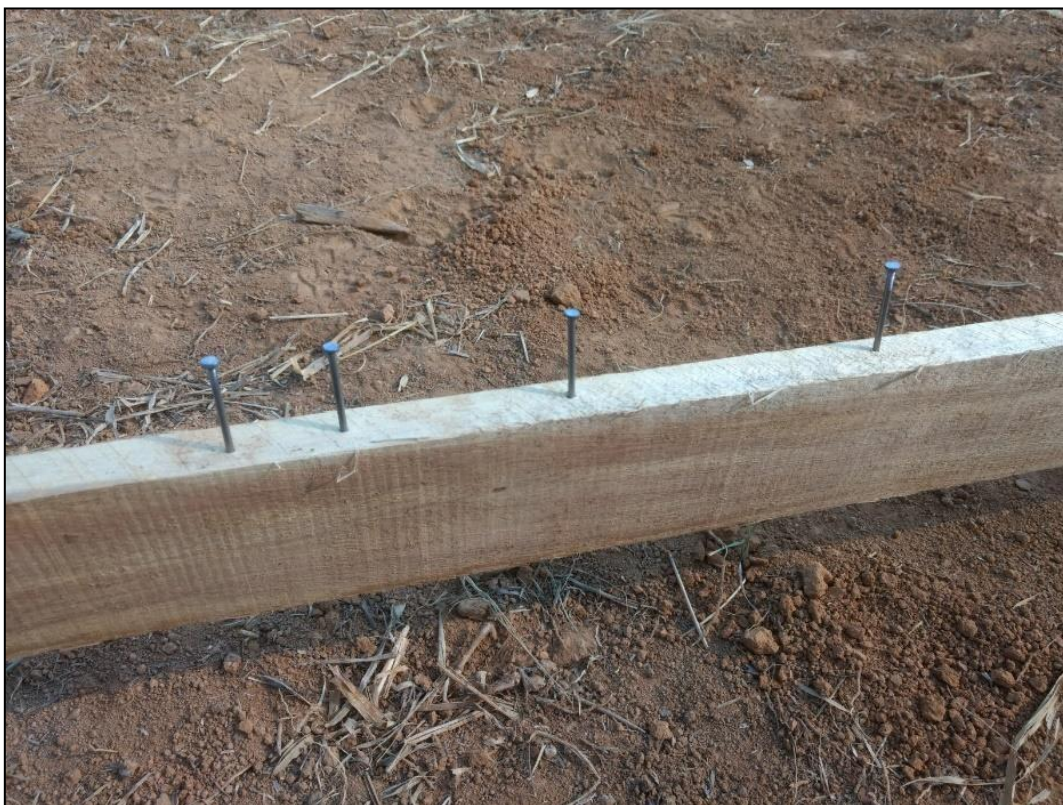
Figura 6 – Execução dos eixos para realização da locação
