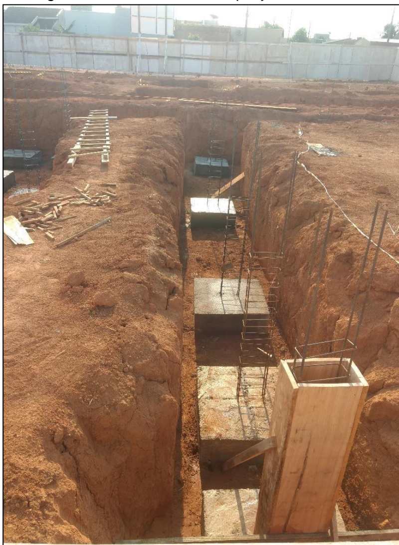
Figura 15 – Pilares de arranque já executados
