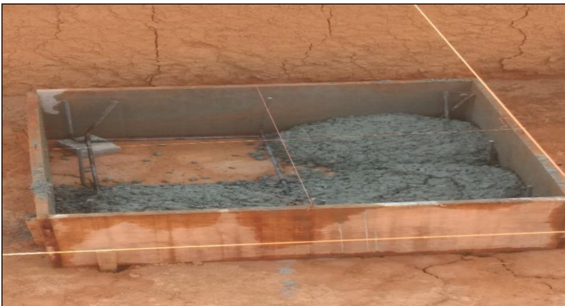
Figura 13 - Processo de concretagem das sapatas de 90x90 cm
