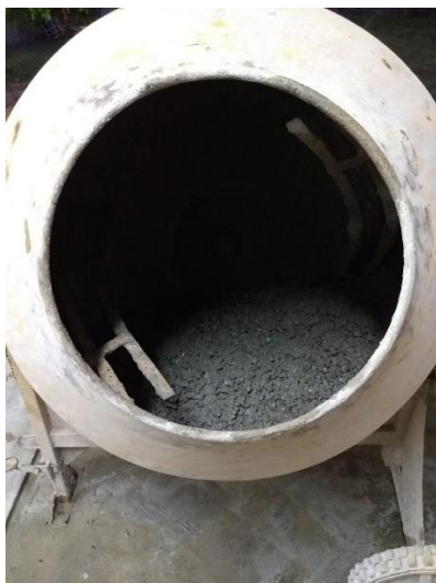
Figura 13: Produção do concreto.
