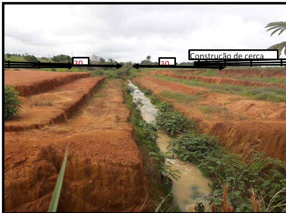
Figura 08 – Curso de água com taludes de contenção
