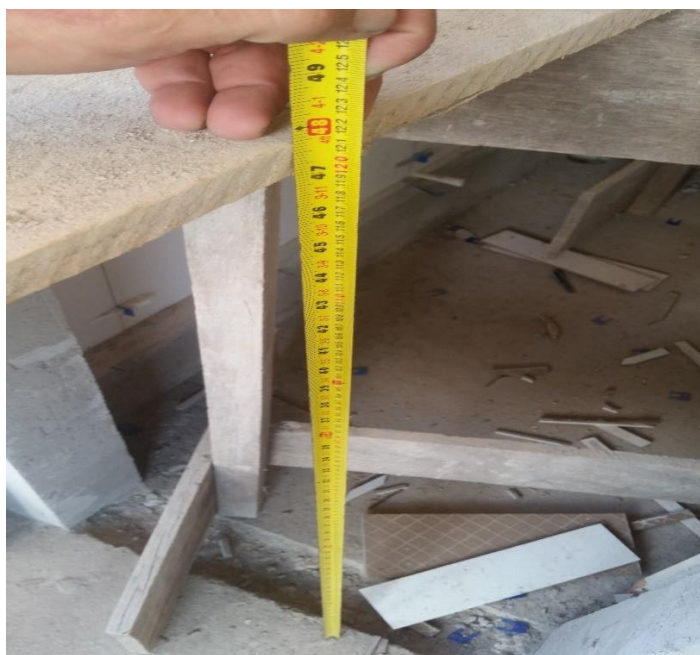
Figura 3 – Altura do andaime
