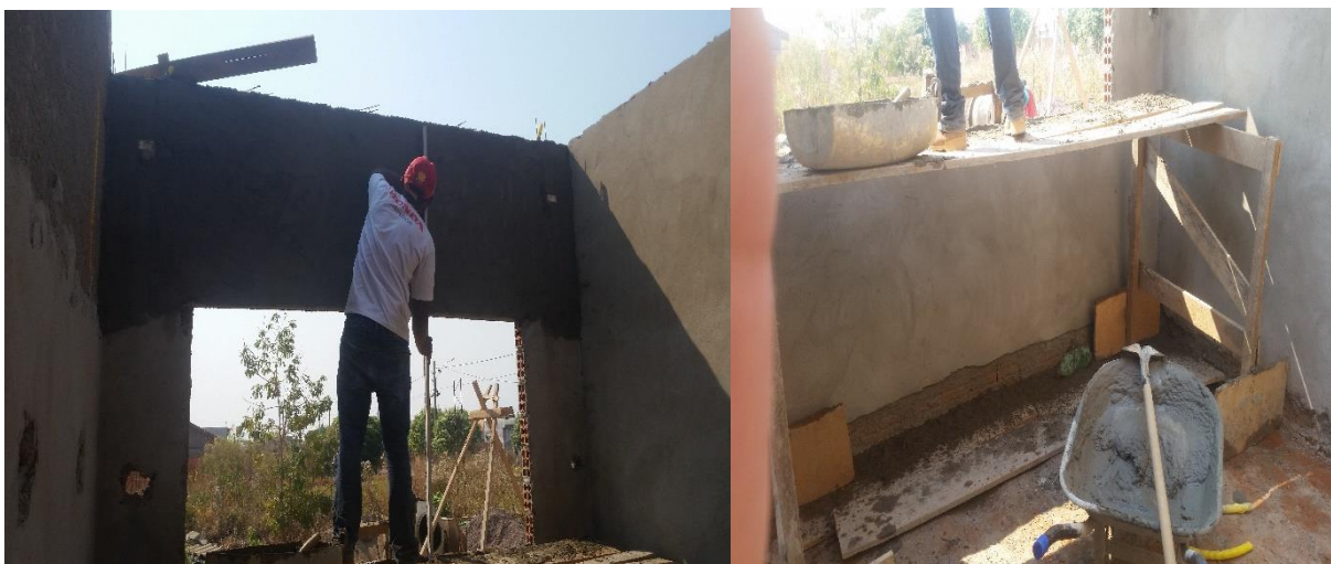
Figura 10 – Execução do reboco da parte interno do residencial unifamiliar
