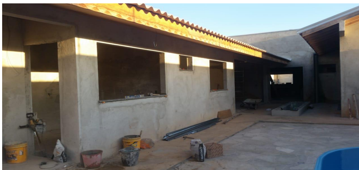
Figura 1 – Vista da primeira construção em estudo
