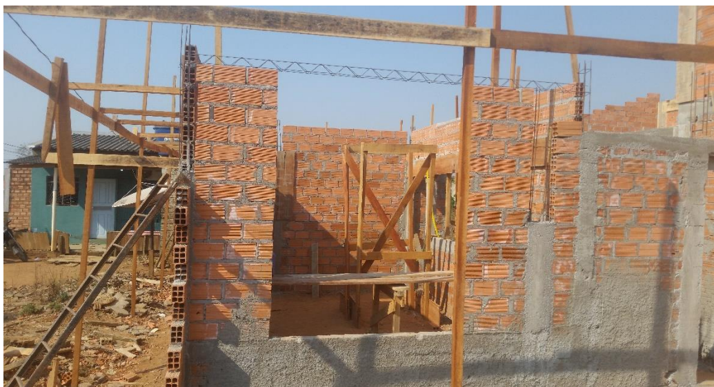
Figura 6 – Vista frontal da terceira obra em estudo
