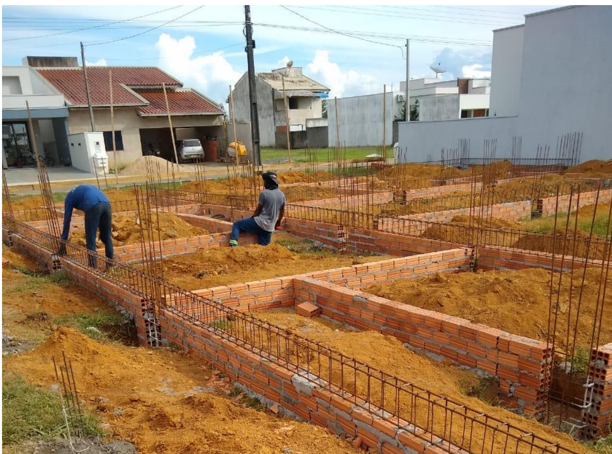
Figura 5 – Execução da parte estrutural do residencial unifamiliar
