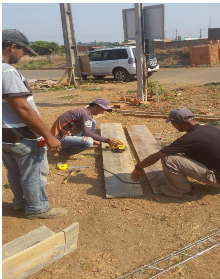
Figura 8 – Confeções de fôrmas para concretagem
