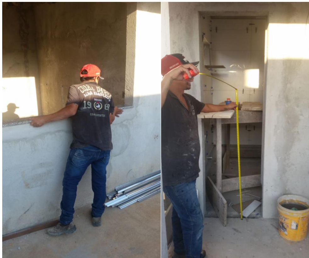
Figura 2 – Assentamento de mármore e revestimento cerâmico da obra em estudo
