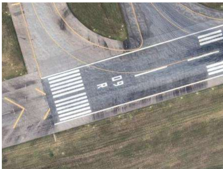
Figura 4 - Cabeceira da Pista de Pouso e Decolagem
