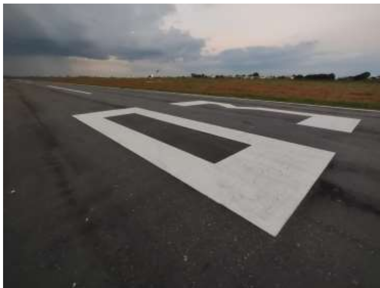
Figura 17 - Sinalização de designação da PPD conforme Norte Magnético
