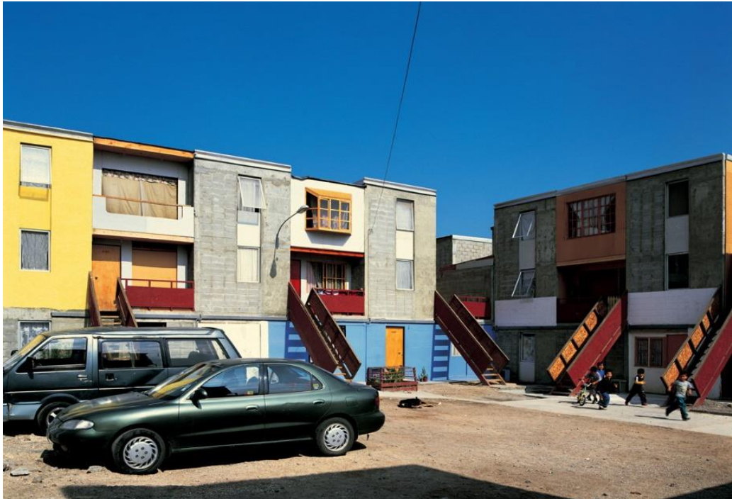
Figura 49 - Vista 03 pós ocupação.
