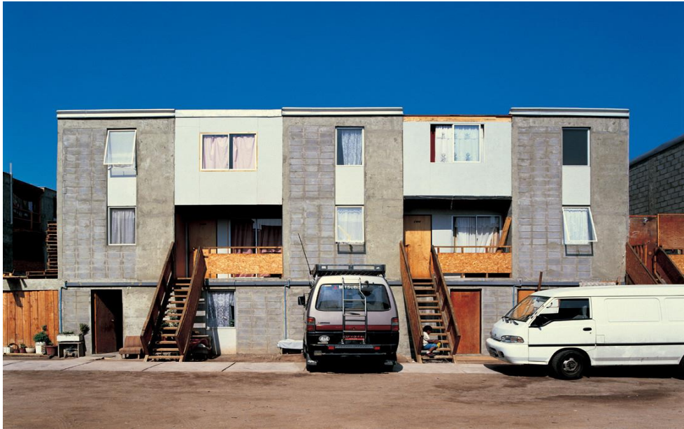
Figura 47 - Vista 02., pós ocupação.
