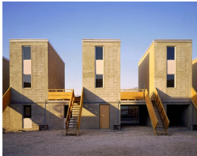
Figura 35: Fachada Quinta Monroy, antes da ocupação.
