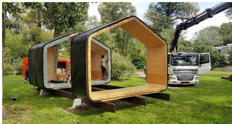
Figura 2 - Wikkihouse em montagem.
