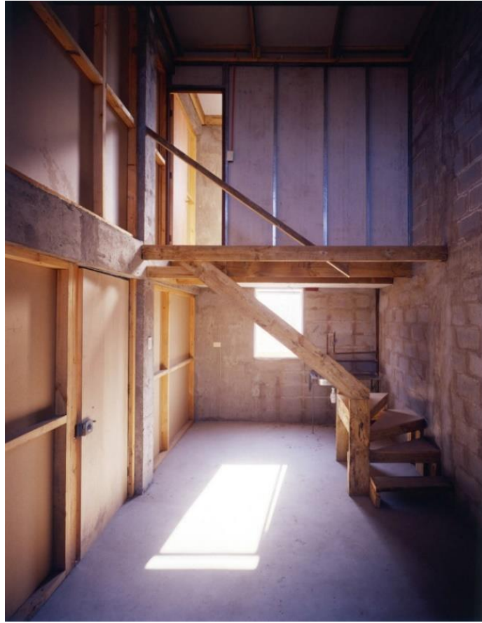
Figura 51 - Interior pavimento térreo.
