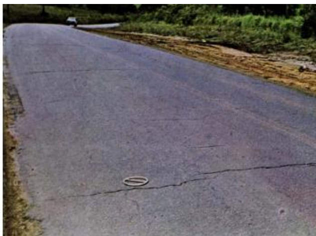
Figura 17 Trinca transversal
