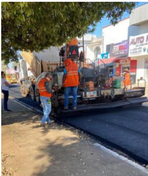
Figura 36 Recapeamento na Avenida Canaã
