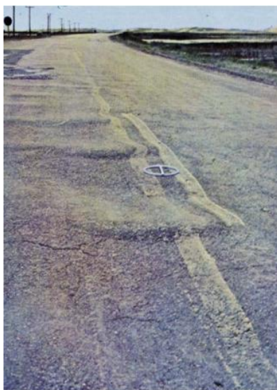
Figura 11 Ondulações ou corrugações
