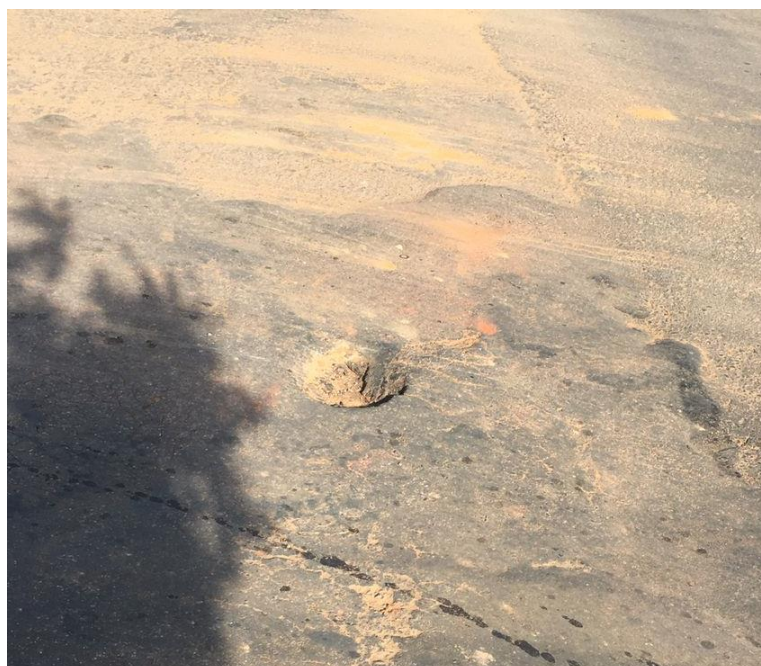
Figura 39 Painela no Trecho C após o recapeamento
