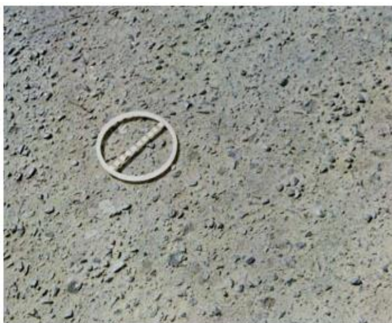
Figura 5 Desgaste
