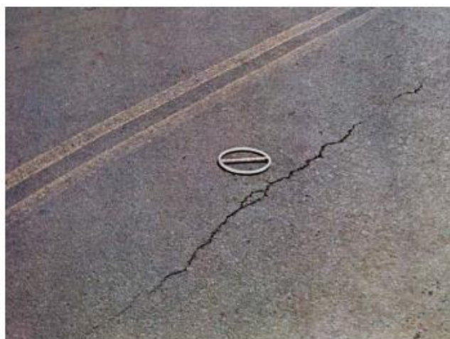
Figura 18 Trinca longitudinal
