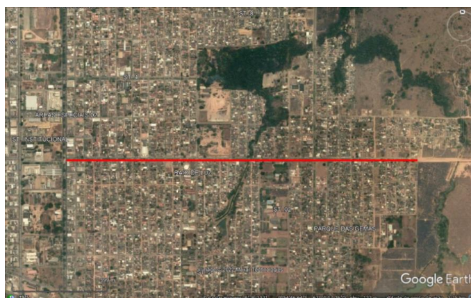
Figura 24 Extensão da Avenida Canaã, Google Earth
