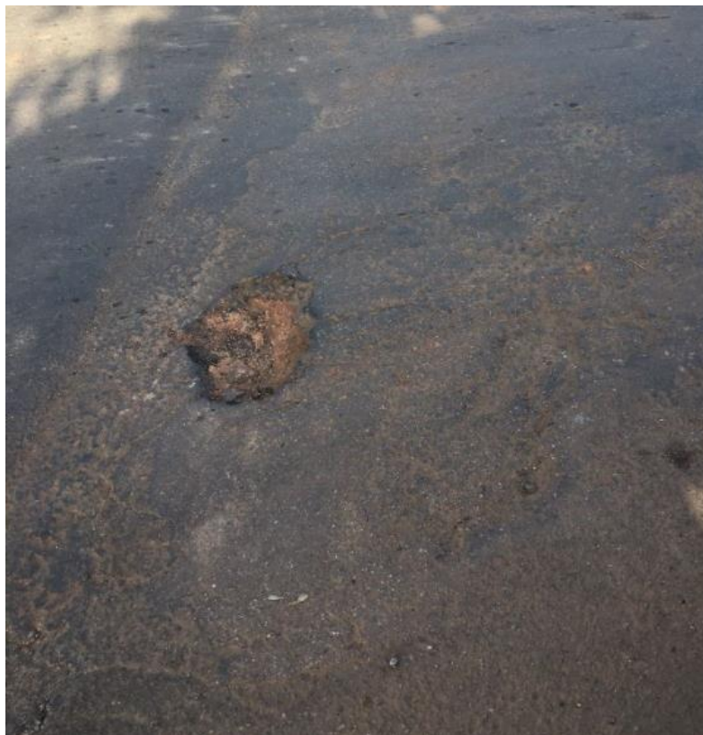
Figura 38 Painela no Trecho C após o recapeamento
