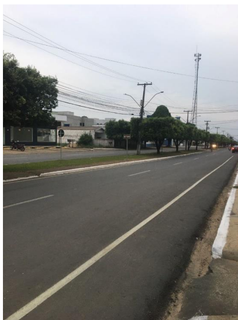
Figura 37 Recapeamento da Avenida Canaã
