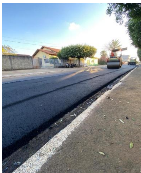
Figura 35 Recapeamento na Avenida Canaã
