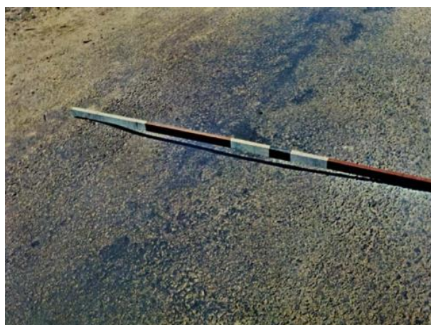
Figura 13 Afundamento local
