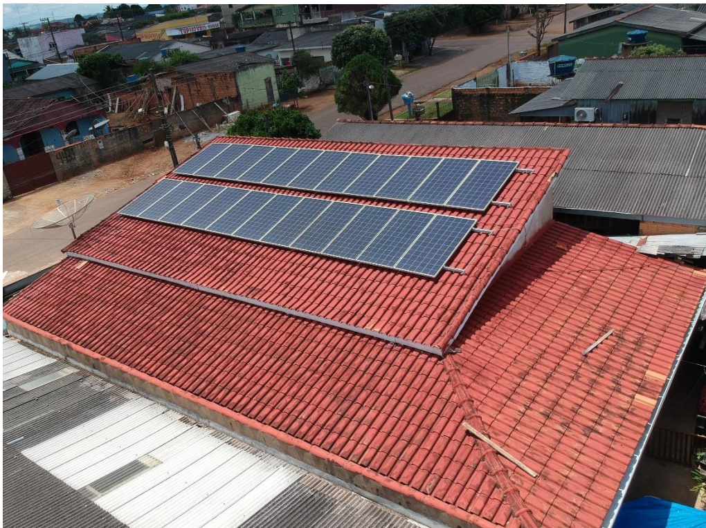
Figura 14 - Módulos Fotovoltaicos Instalados.
