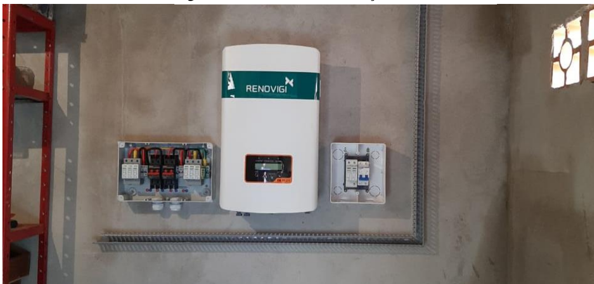
Figura 11 - Processo de Instalação do Inversor.
