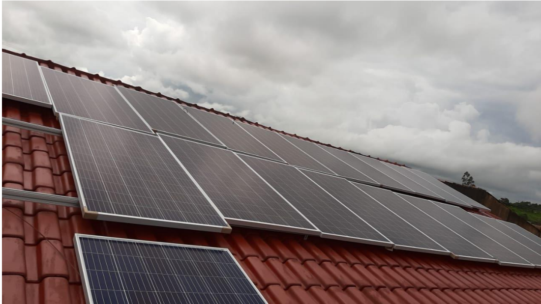
Figura 13 - Instalação dos Módulos Fotovoltaicos.
