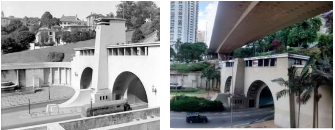
Figura 7 – Túnel 9 de julho, década de 1940, depois 2015.
