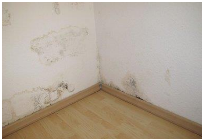
Figura 5 - Infiltração
