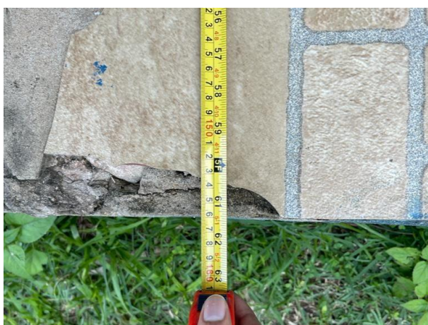
Figura 22 - Medição de área de piso 02
