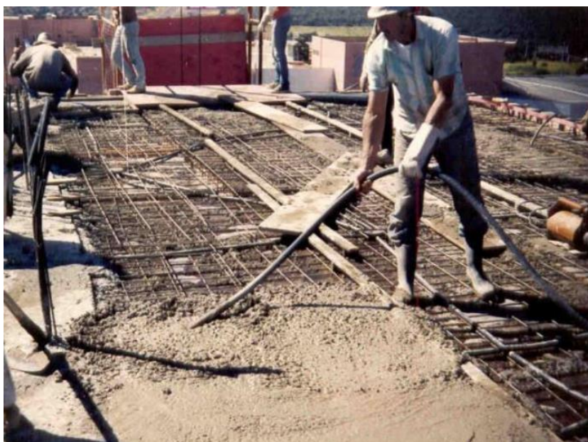
Figura 4 - Laje maciça sendo concretada
