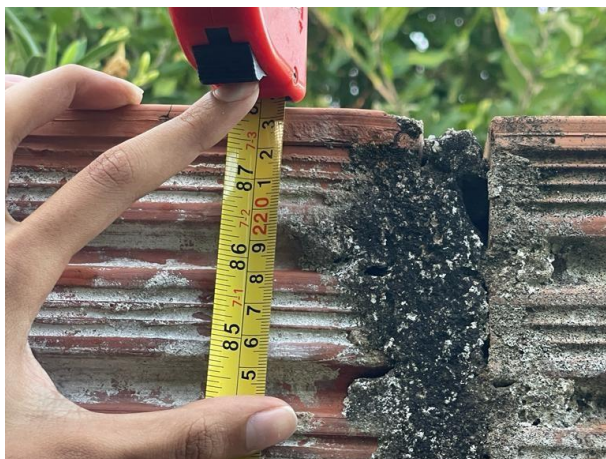
Figura 24 - Medição da altura do muro
