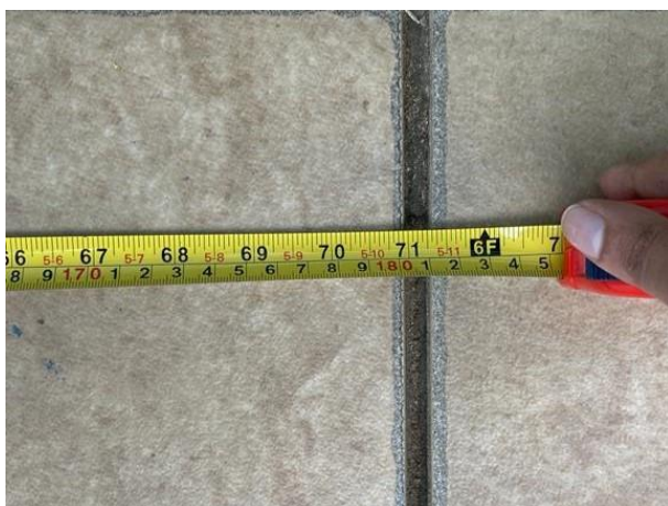
Figura 21 - Medição de área de piso 01
