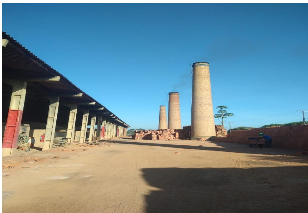
Figura 9 – Vista do pátio externo e fornos da indústria de tijolos
