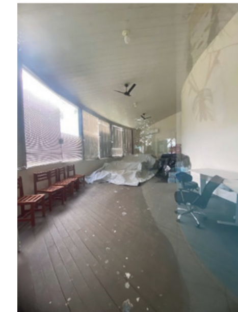
Hall de acesso
