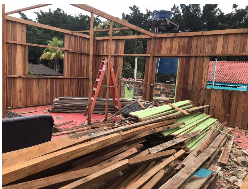
Figura 14 – Canteiro de obras 3
