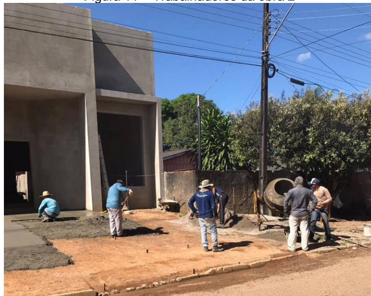
Figura 11 – Trabalhadores da obra 2
