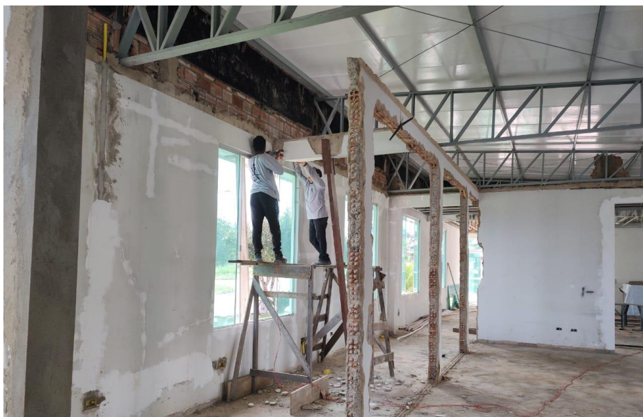
Figura 10 – Andaime da obra 1
