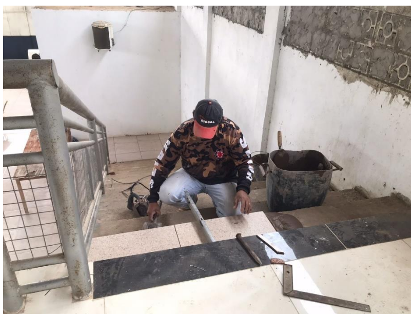
Figura 15 – Assentamento cerâmico da obra 4
