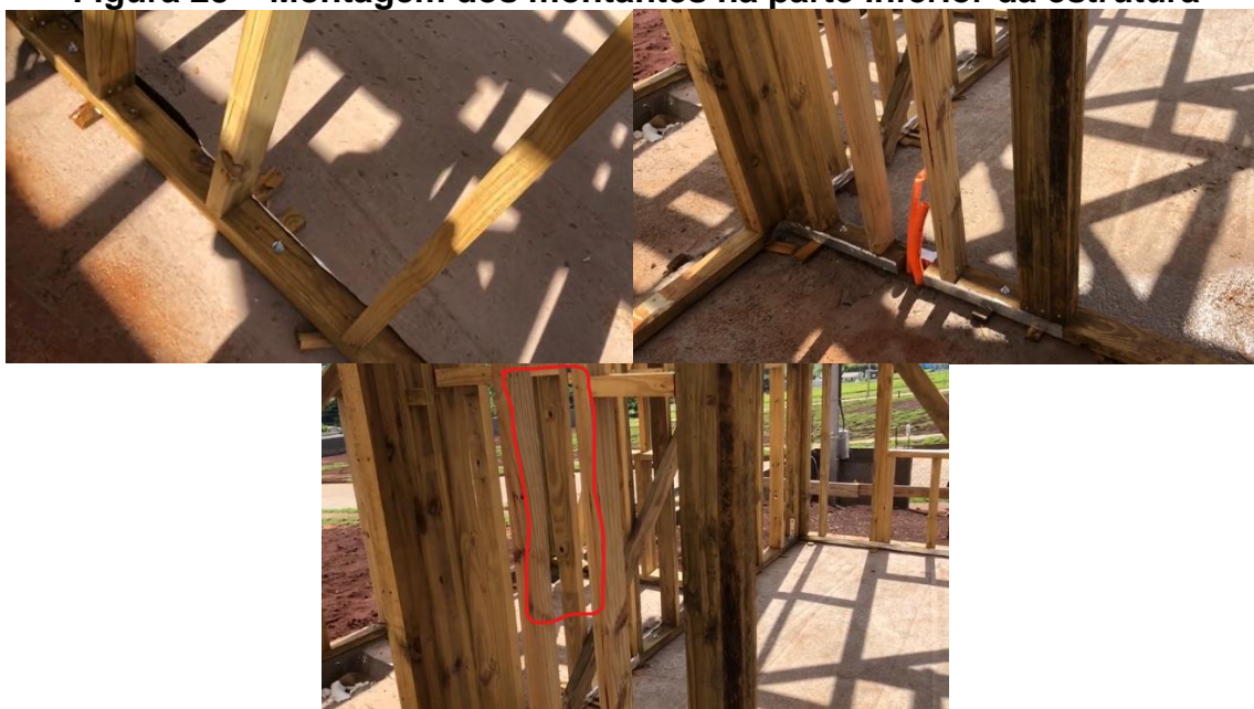
Figura 23 – Montagem dos montantes na parte inferior da estrutura
