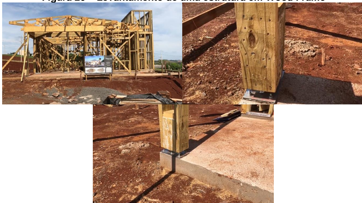
Figura 20 – Levantamento de uma estrutura em Wood Frame
