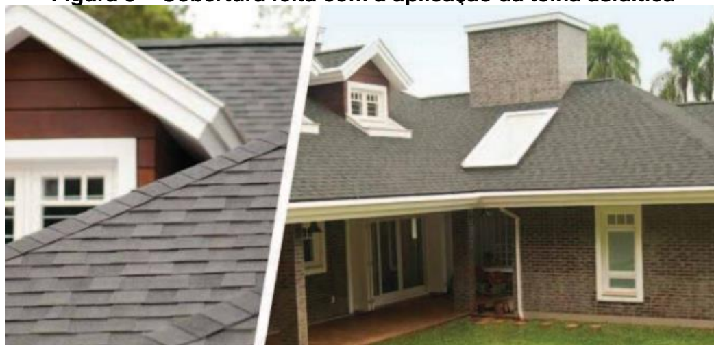
Figura 5 – Cobertura feita com a aplicação da telha asfáltica
