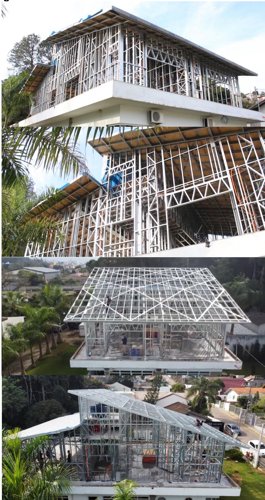
Figura 18 – Levantamento de uma estrutura em Steel frame
