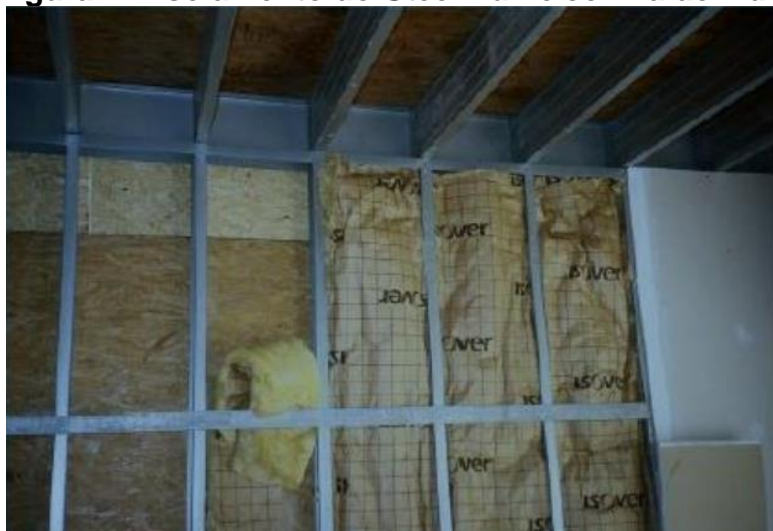
Figura 7 – Isolamento do Steel frame com lã de vidro
