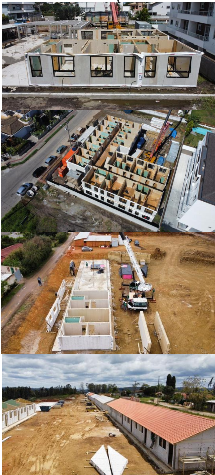
Figura 27 – Detalhes da construção de casas em Wood frame
