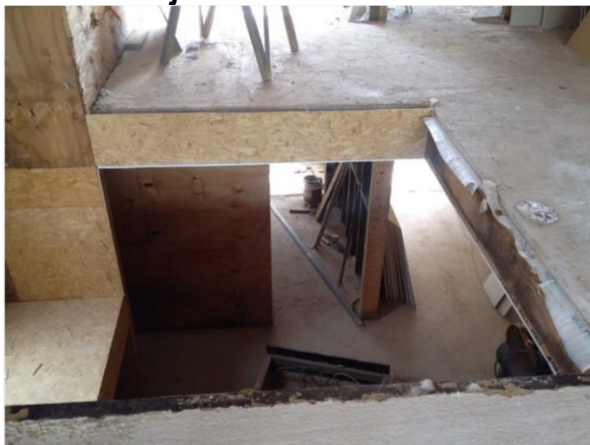
Figura 12 – Laje com camada fina de concreto
