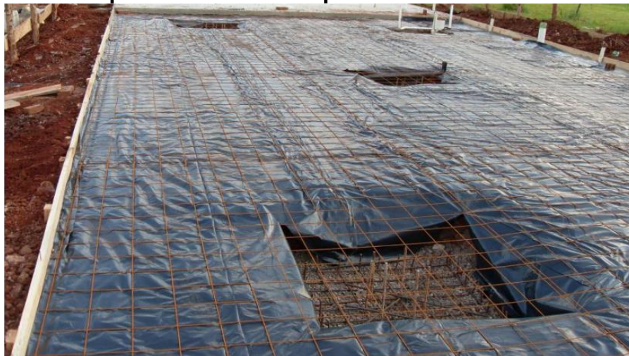
Figura 2 – Radier precisando do estaqueamento e blocos sobre as estacas
