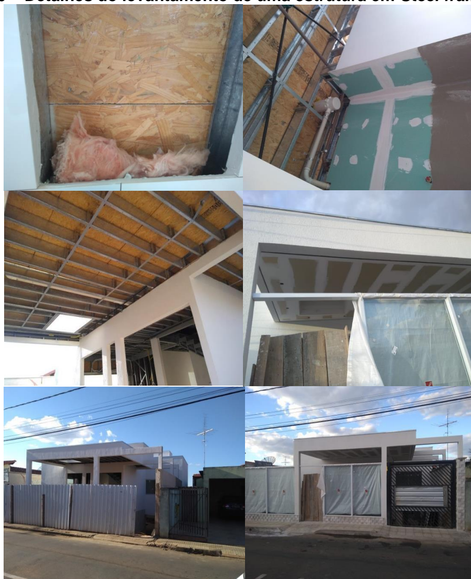
Figura 26 – Detalhes do levantamento de uma estrutura em Steel frame em MG
