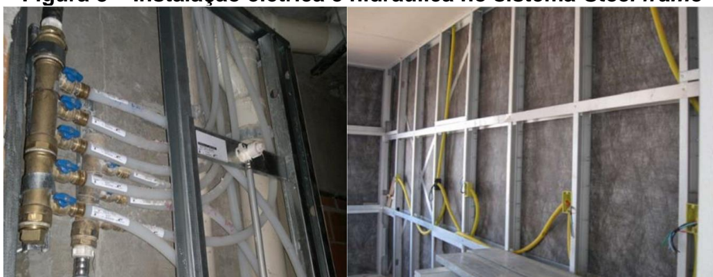
Figura 8 – Instalação elétrica e hidráulica no sistema Steel frame
