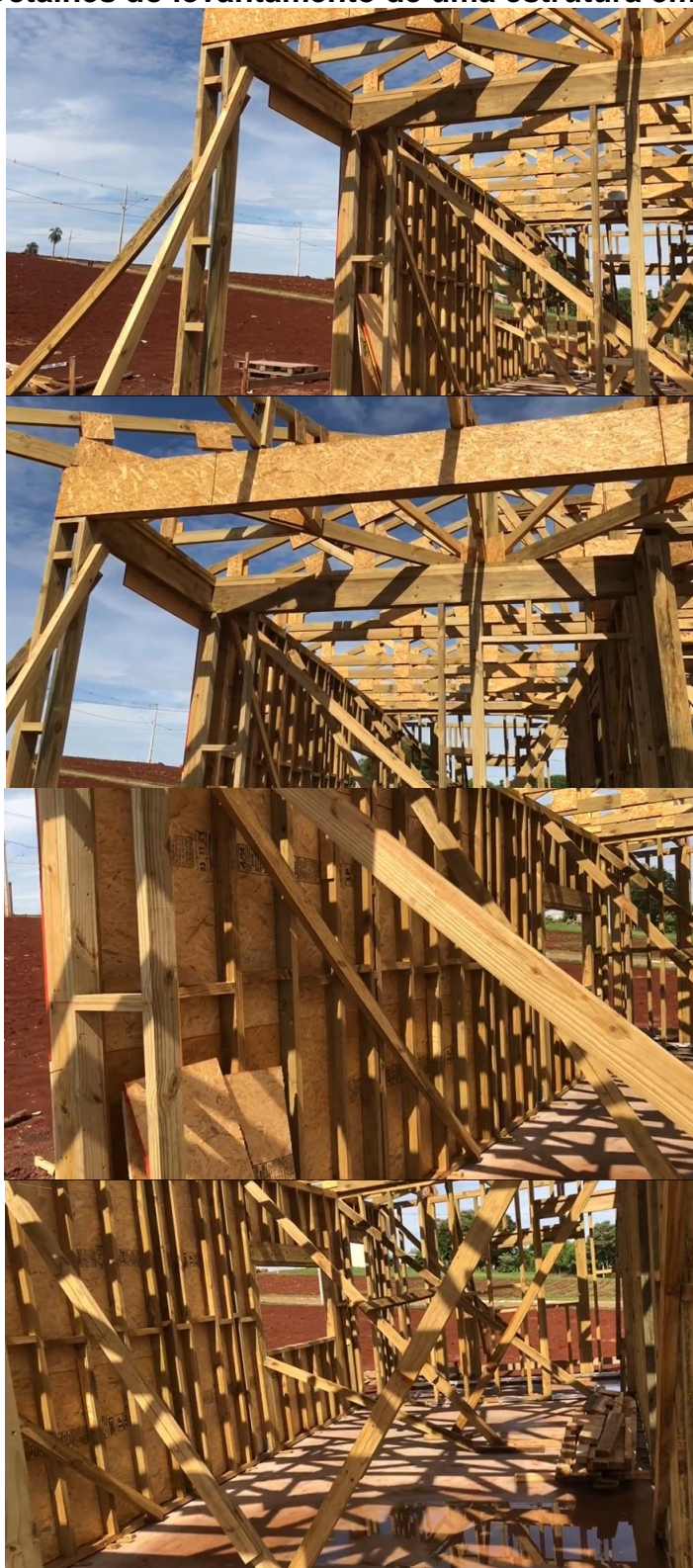
Figura 21 – Detalhes do levantamento de uma estrutura em Wood Frame
