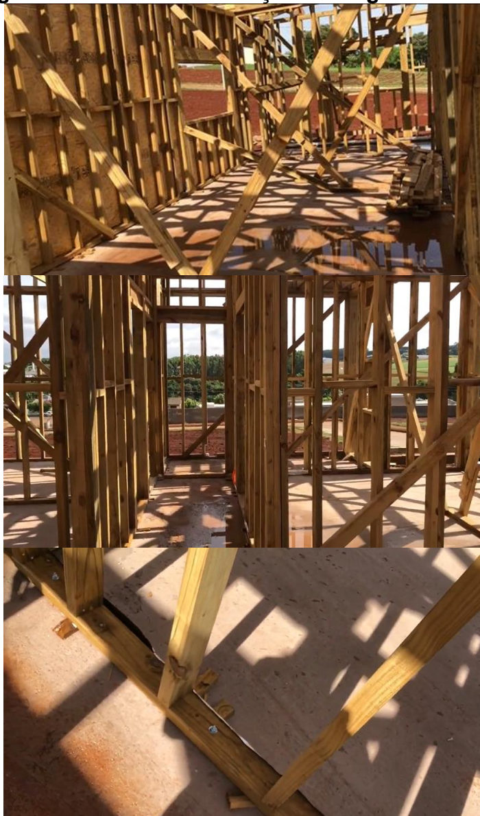
Figura 22 – Vigas de contravento e fixação das vigas chumbador mecânico
