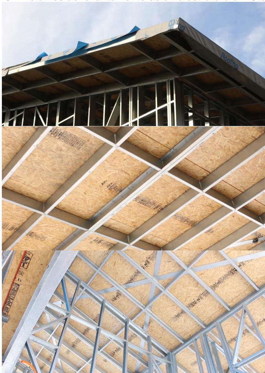
Figura 19 – Detalhes do levantamento de uma estrutura em Steel frame
