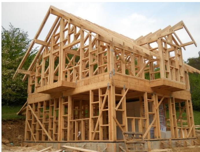
Figura 9 – Detalhe da casa pré-montada em Wood frame
