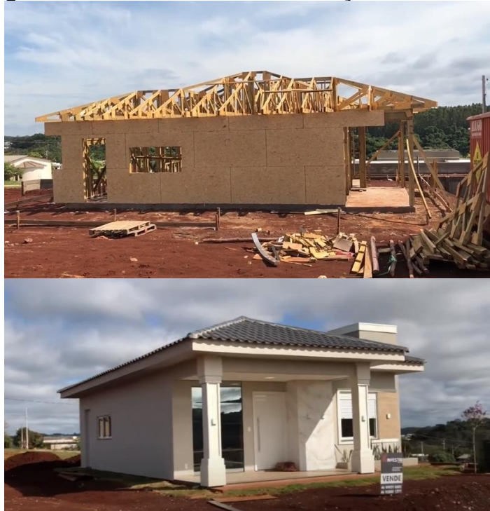
Figura 24 – Fechamento e finalização da estrutura
