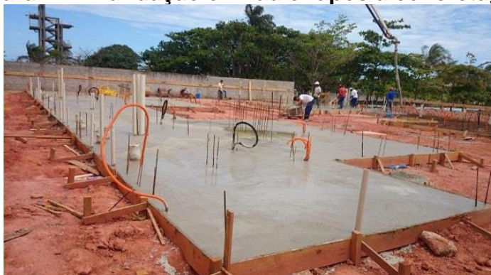
Figura 11 – Fundação em radier após a concretagem
