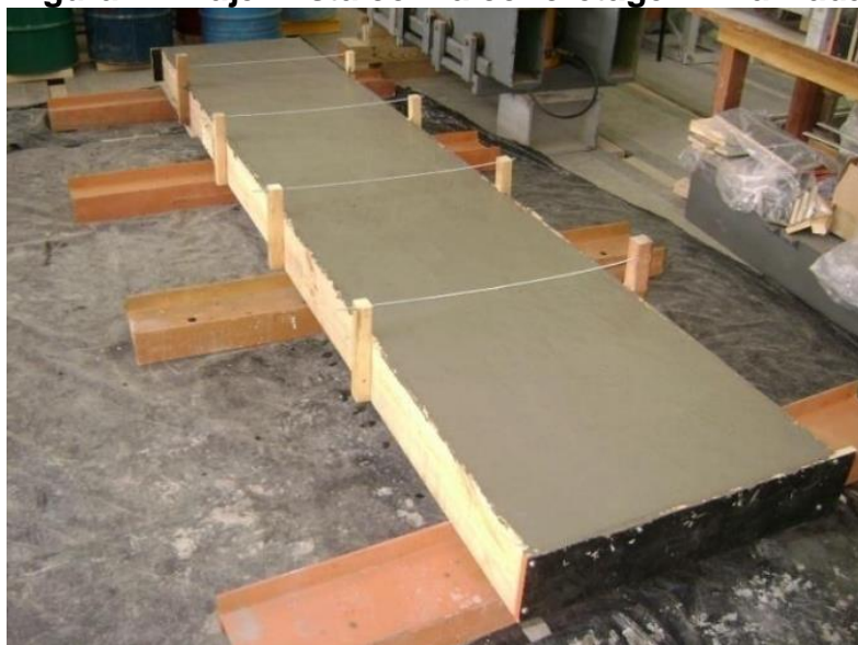
Figura 4 – Laje mista com a concretagem finalizada
