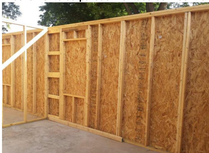
Figura 14 – Fechamento da parede montada com contraventamento
